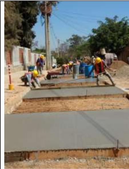
Reposición de concreto hidráulico o asfalto en áreas ya concluidas
