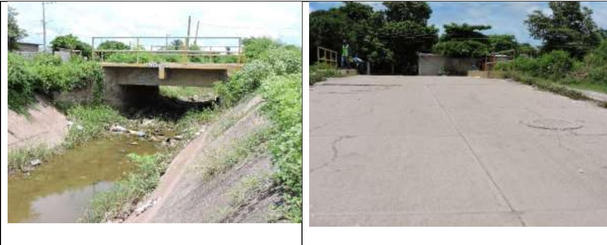
Fotografías donde se denota que el cruce de la tubería se efectuara en un sitio donde ya existe la presencia de una obra enfocada al paso vehicular y peatonal, asimismo, en ambos margenes de esta corriente ya se tiene una vialidad dode el transito de vehiculos es continua, ademas de denotarse el alto grado de contaminación que existe en el área y tratarse de un cauce ya delimitado con material constructivo.
