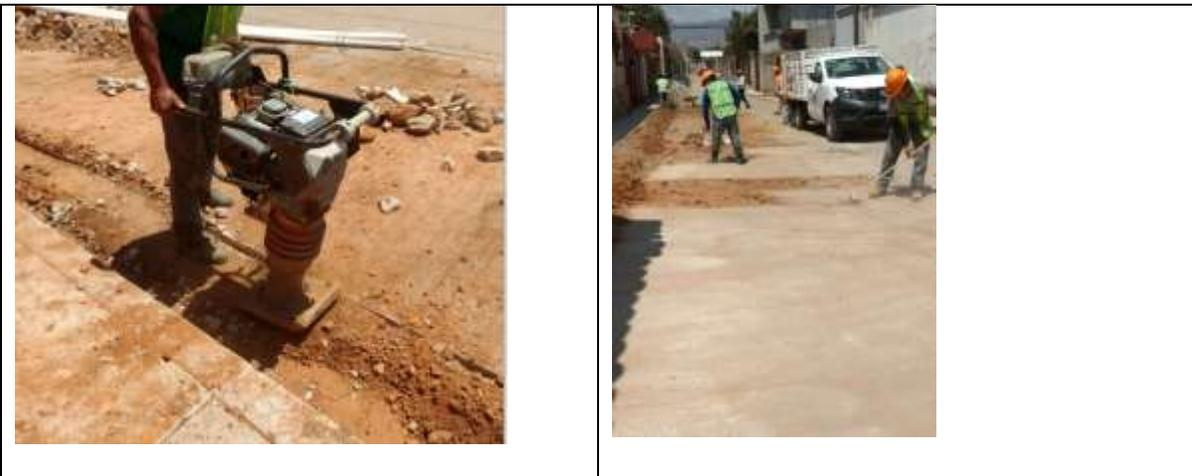
Compactación del relleno de las zanjas y limpieza del área de trabajo
