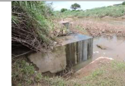
Fotografías donde se observa el colapso del alcantarillado existente, donde las aguas residuales son conducidas por calles pavimentadas y llegan a calles de tierra, donde se afecta el suelo y en su caso las aguas subterráneas, además de pasar de manera aledaña en viviendas y lo cual
