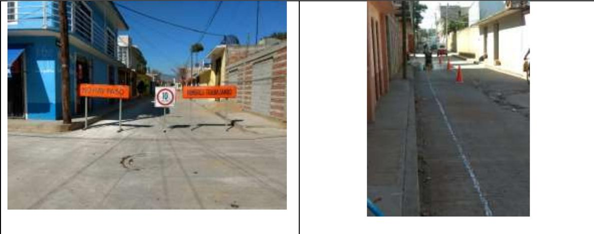
Fotografías ilustrativas enfocadas a la delimitación del área de trabajo, limpieza y trazo del sitio donde irían la tubería e incluso se observa acciones de corte del pavimento.
