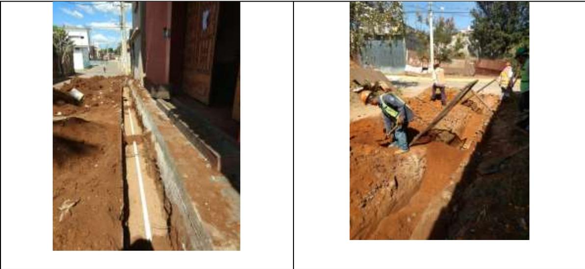
Colocación de plantilla, colocación de tubería y relleno de la zanja.
