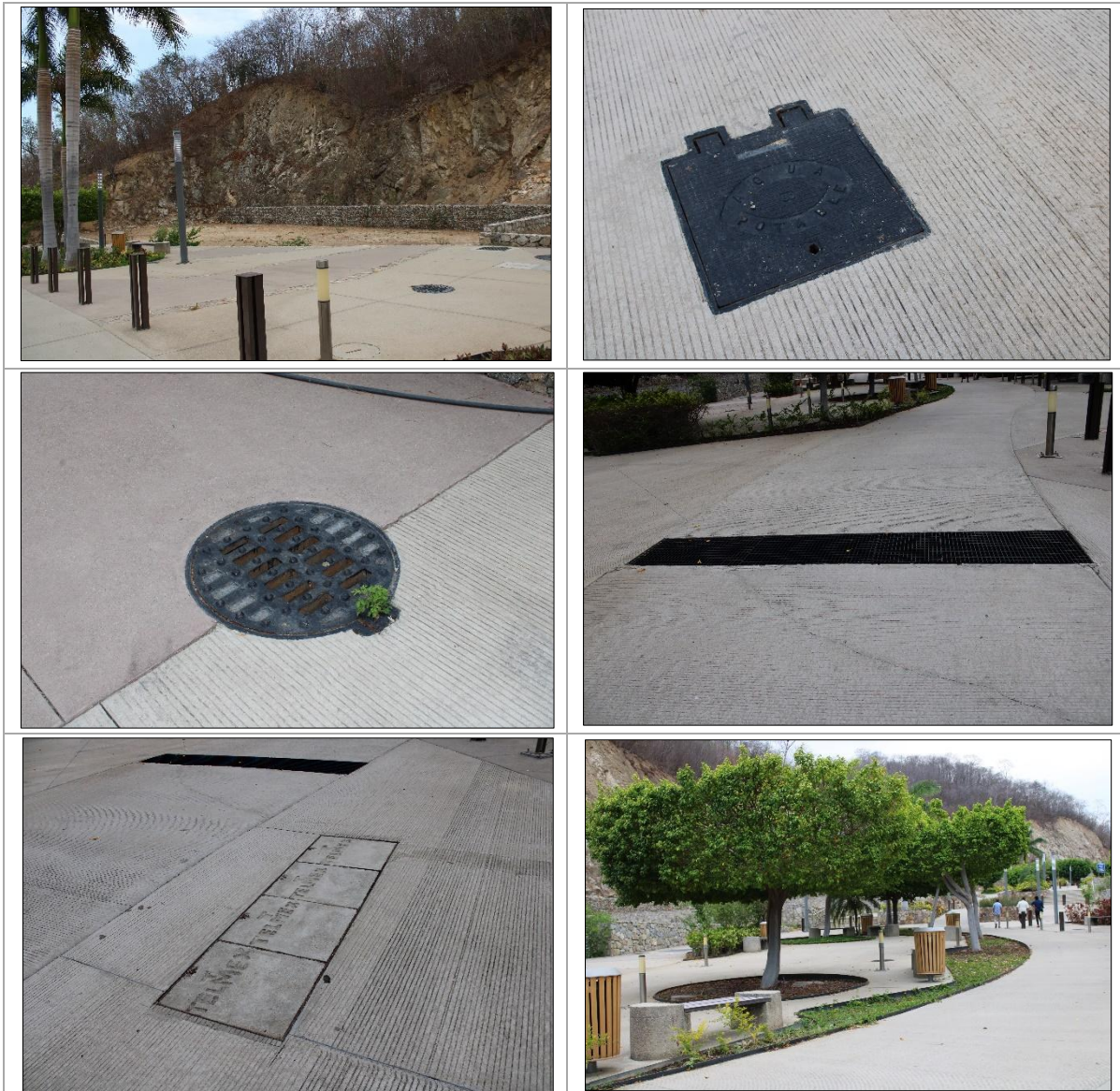
Figura II.4- Se pueden observar los distintos servicios públicos que se cuentan en la zona del proyecto, de tal manera que por su ubicación y naturaleza del proyecto es viable su implementación.
