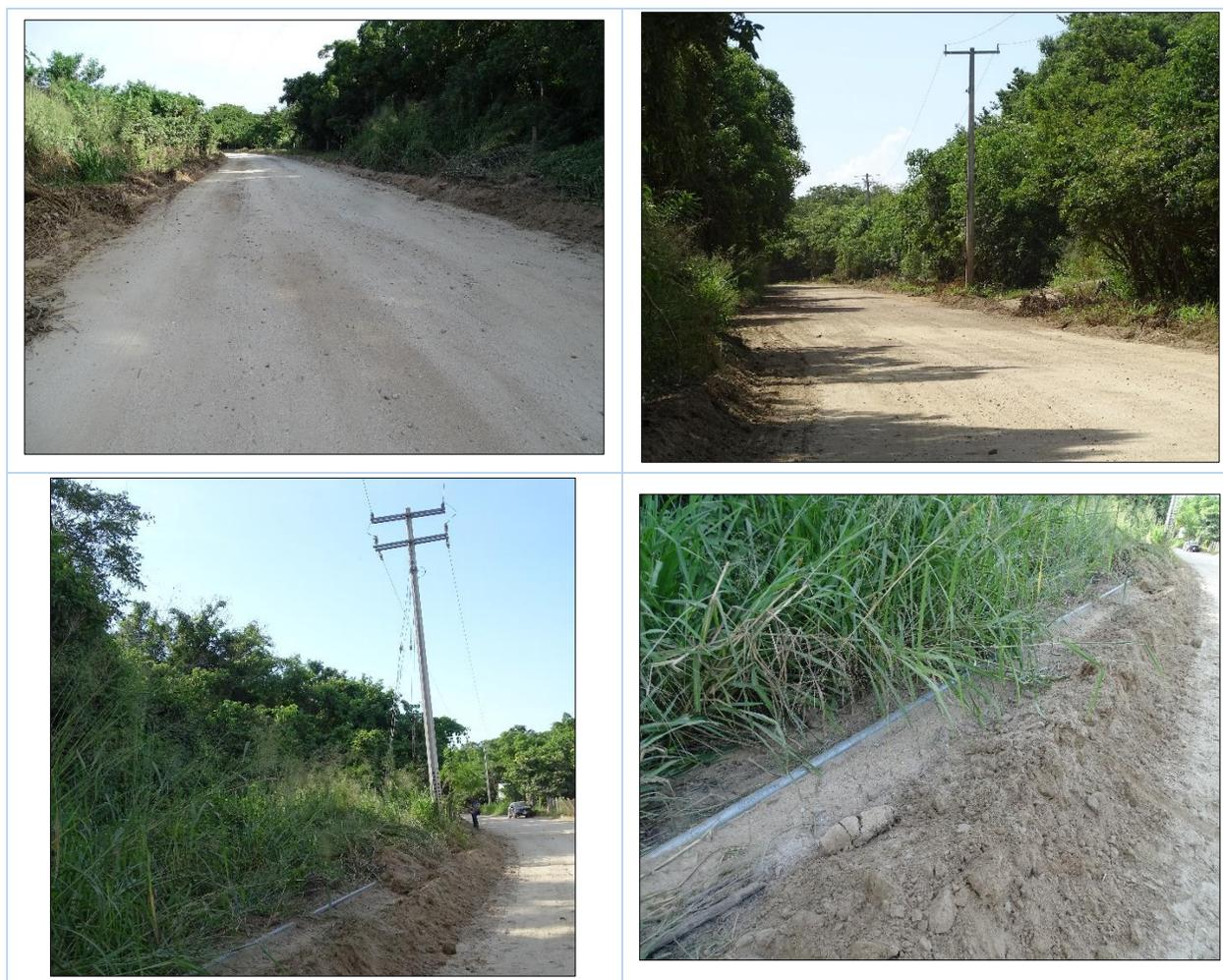
**Figura II.6** En las fotografías se puede apreciar el entronque del camino de acceso con la Carretera Federal 200, de la misma manera el camino de acceso existente con dimensiones para el tránsito de dos vehículos en buen estado de conservación, de la misma manera se observa que existen postes de energía eléctrica funcionando, así como tubería galvanizada de agua potable que va acorde al camino existente hasta la Bahía de San Agustín.
