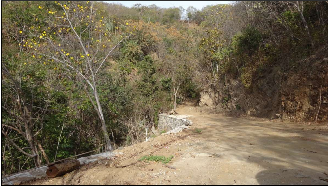
Imagen II.4 Terraplén y Muro 1.
