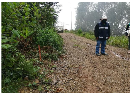
Figura 4.31. Km, 0+000 Camino existente
