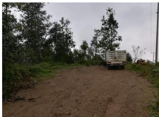
Figura 4.31. Km, 0+020 Camino existente
