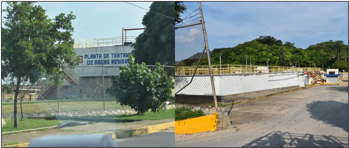
Figura IV-43. Planta de tratamiento de aguas residuales en la localidad de Lagunas, El Barrio de la Soledad.
