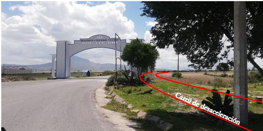
Ilustración IV.29 Carril de desaceleración; sección: Entronque carretera Estatal a Itzoteno y carretera Federal 140 km 0+220.
