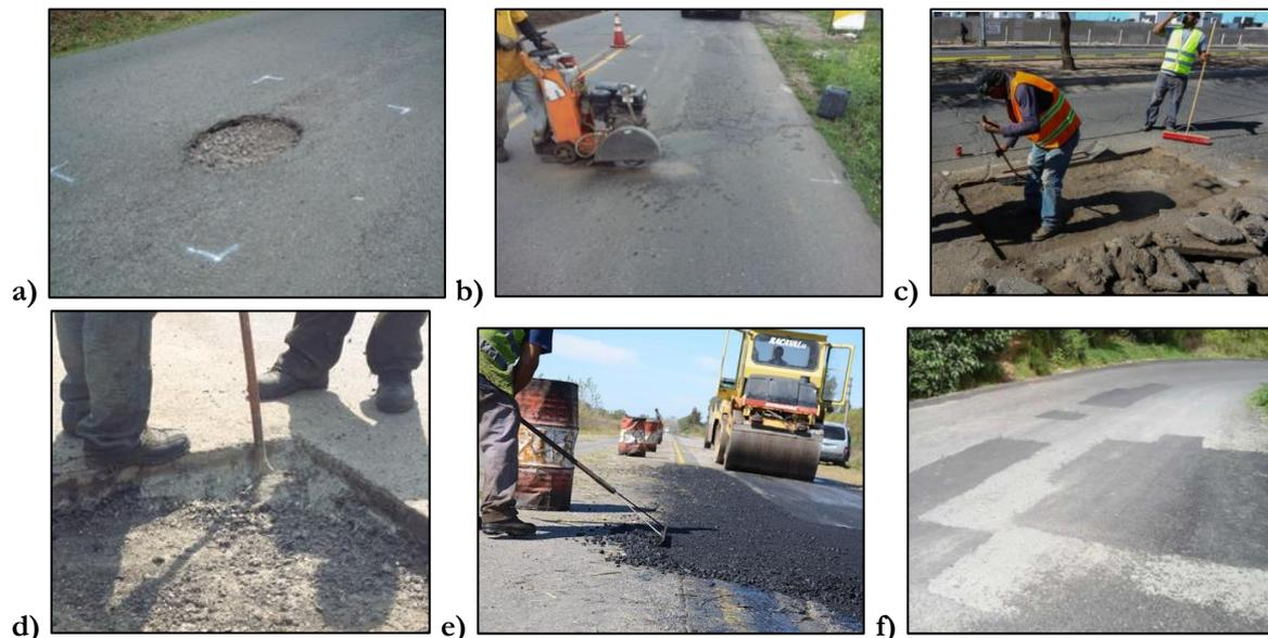
Ilustración II.11. Etapas de bacheo superficial: a) Delimitación, b) Corte, c) Retiro de material, d) Limpieza, e) Tendido de mezcla y compactación y f) Acabado.
