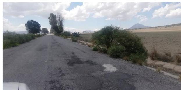
Ilustración VIII.16. Condición de la carretera estatal a Itzoteno sujeta a mejoramiento superficial..
