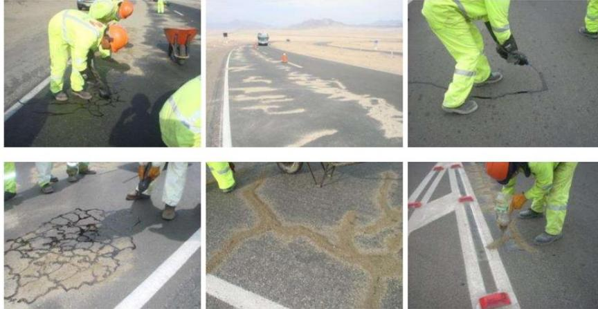
Ilustración II.12. Ejemplo de calefateo y sellado de juntas.
