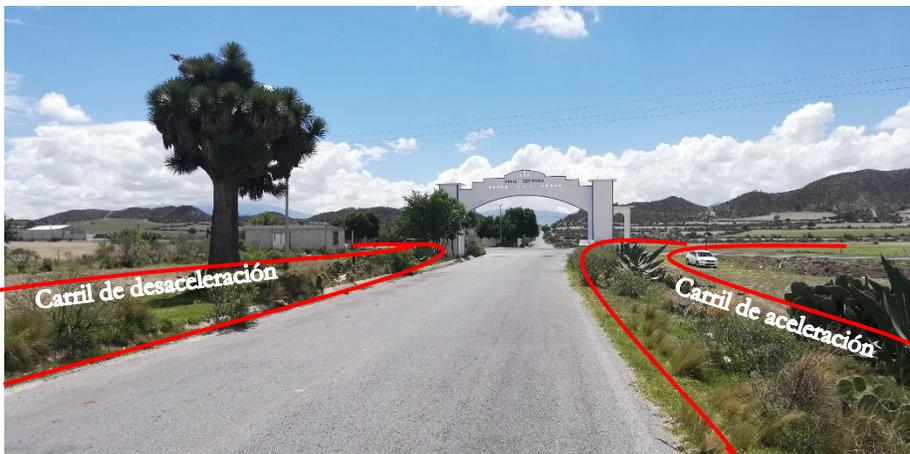
Ilustración IV.30 Carriles de aceleración y desaceleración; sección: Entronque carretera Estatal a Itzoteno y carretera Federal 140 km 0+000.
