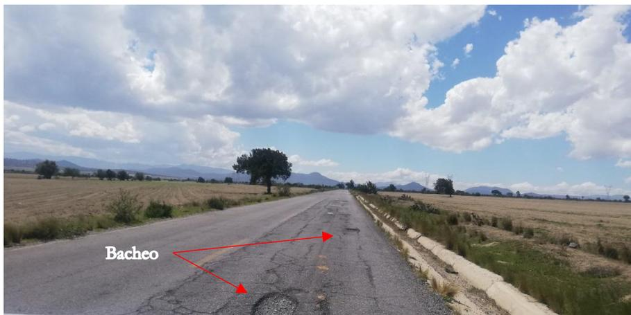
Ilustración IV.27 Condición actual del asfalto; sección: Mejoramiento superficial km 1+940. Vista oeste.
