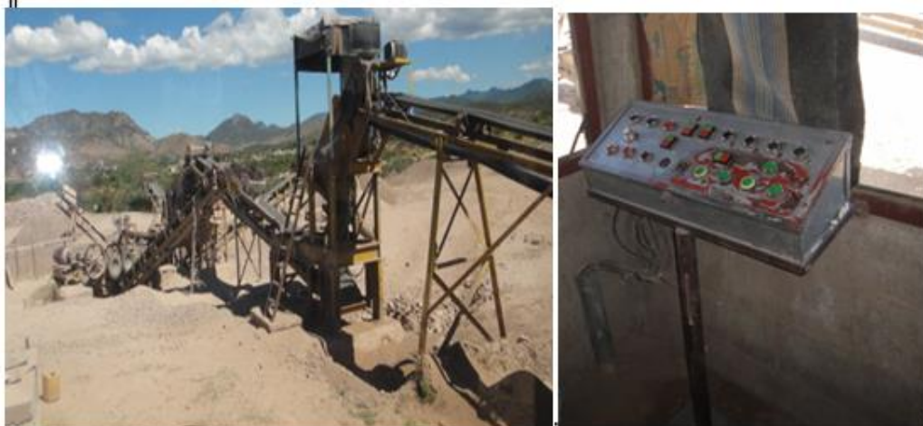
Ilustración 4. Trituradora para producir grava y arena y tablero de control.
