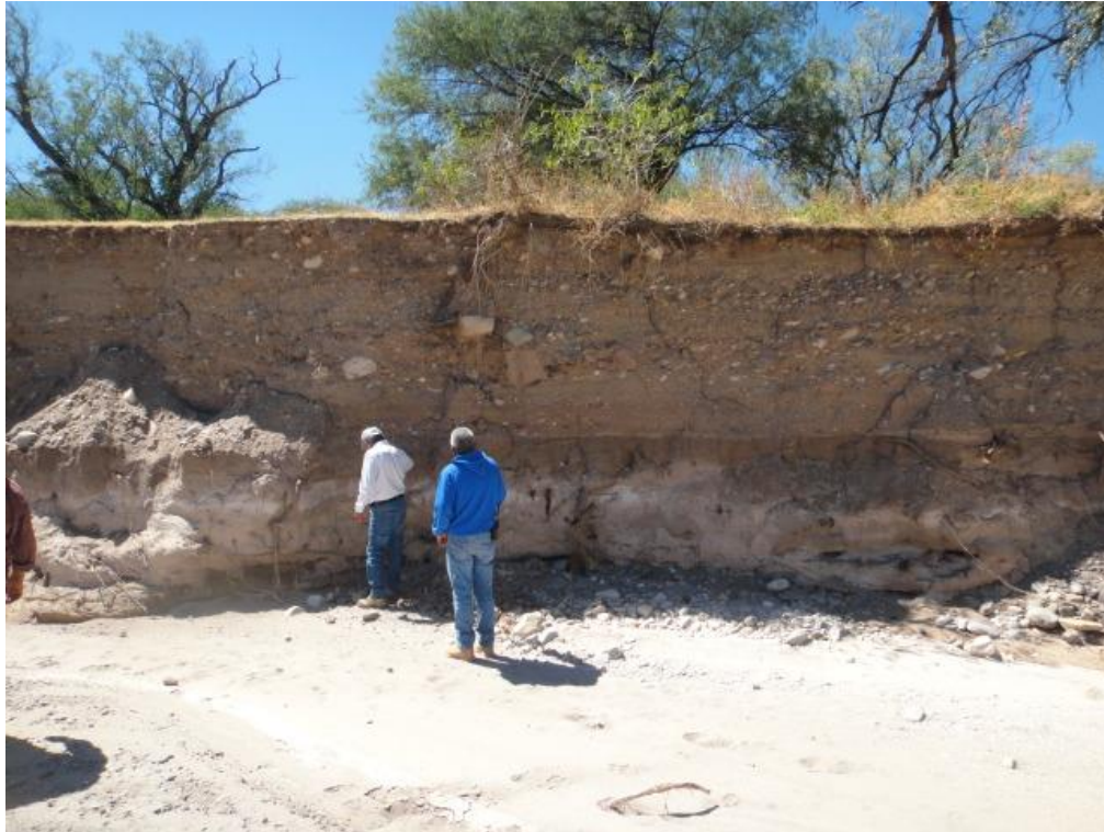
Ilustración 34. Taludes con cenizas volcánicas, material de aluvión y escaso suelo.
