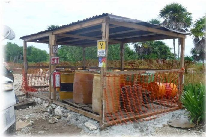
*Figura VI:8 Ejemplo de almacén temporal de residuos peligrosos. Fuente: SYLVATICA, S.C. ®.*
