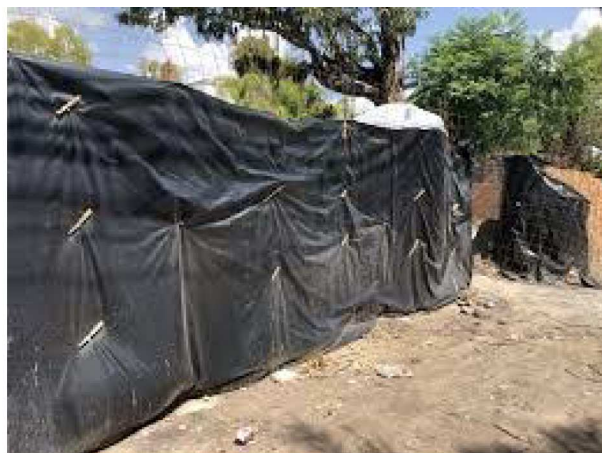
Figura 18. Colocación de malla de retención de polipropileno para delimitar el área de trabajo de obra.
