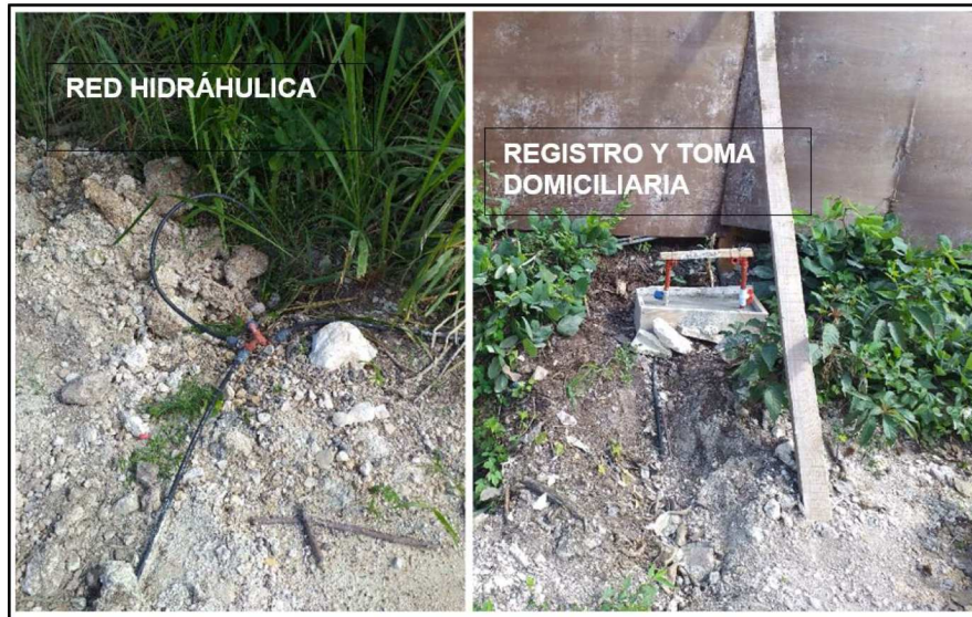
Figura 5. Obras hidráulicas municipal, registro y red de agua potable preparado en el predio para su conexión, toda vez que las obras sean entregadas en su debido momento.
