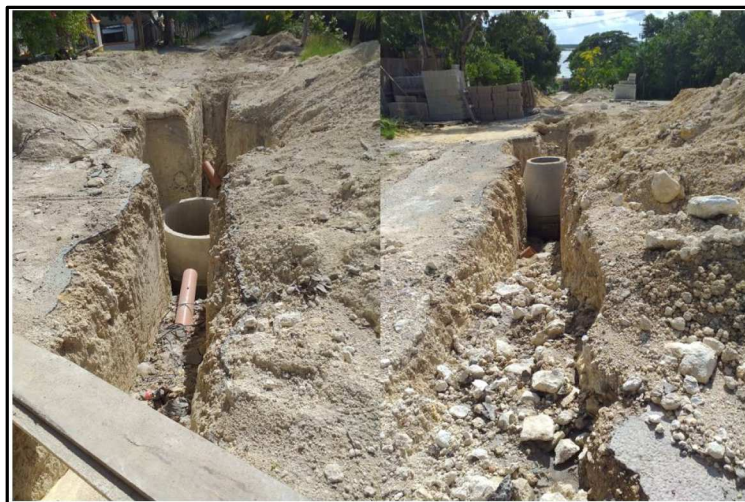
Figura 6. Obras del drenaje municipal, excavación y pozo de reten que ubican frente al predio.
