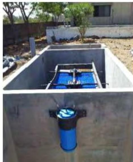
Figura 10. Imagen ilustrativa de SaniTEE en tanque
