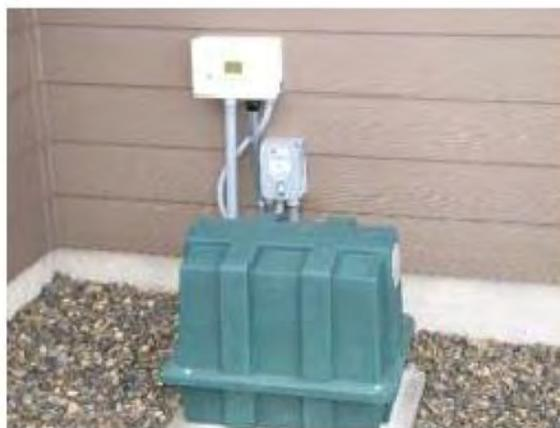
Figura 11. Imagen ilustrativa del Soplador MicroFAST con Housing
