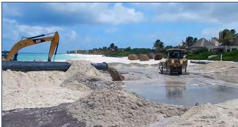
FIGURA 2.22 EJEMPLOS DE ACOMODO DE ARENA CON MAQUINARIA
