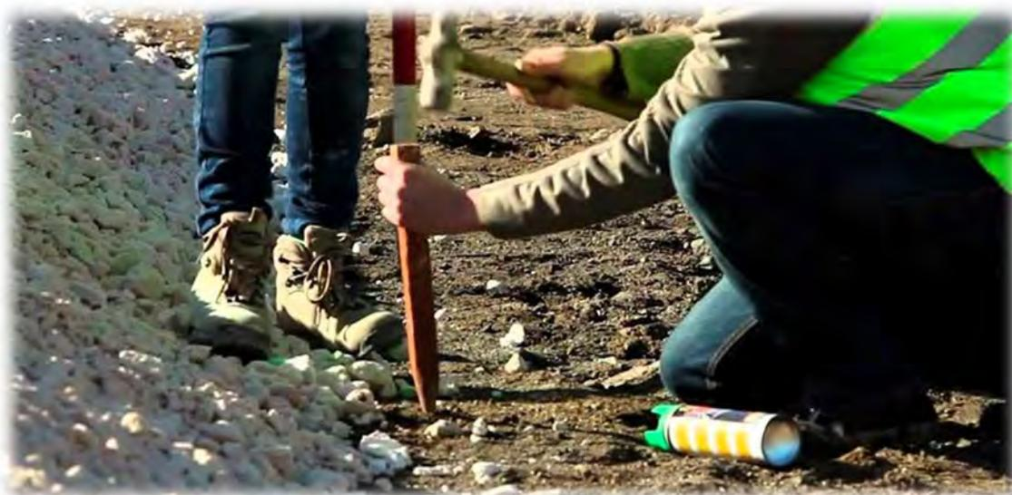
*Figura II:13. Representación fotográfica de la colocación de una estaca*
