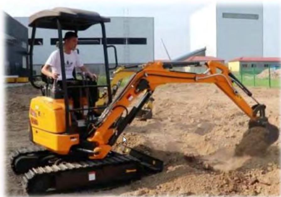
*Figura II:17. Representación fotográfica del despalme con una mini retroexcavadora*
