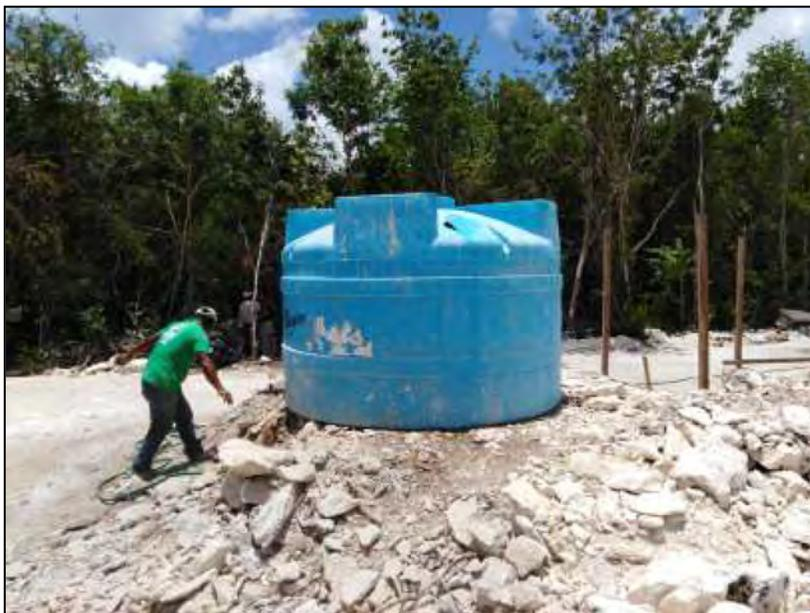
Se colocara una cisterna industrial para almacenar el agua potable, la cual servira en la etapa constructiva del proyecto. La capacidad de almacenamiento sera de 1,000 litros.
