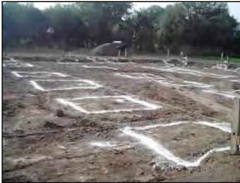
Una vez realizado el trazo, se marcara con cal el lugar exacto donde se realizara la excavación lineal para el alojamiento de la cimentación y de las zapatas que darán soporte a la casa residencial.
