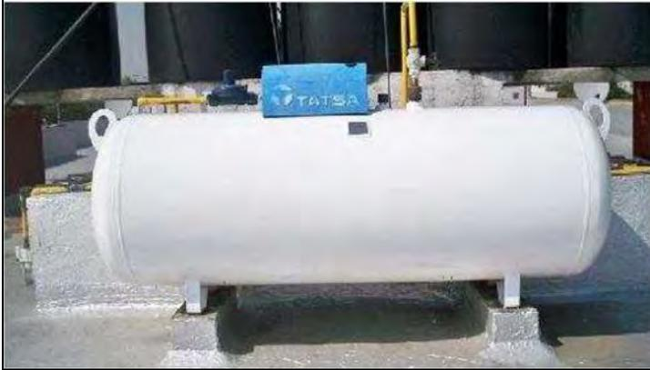
Se instalara un tanque estacionario de combustible tipo gas liquido L.P. de uso doméstico, que servirá para el funcionamiento de la cocina. La capacidad del tanque estacionario sera de 1,000 litros de capacidad, mismo que será abastecido periódicamente por la empresa Z Gas.
