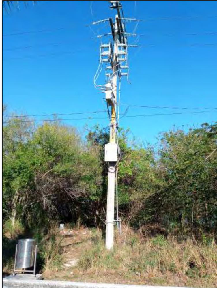
Imagen del sistema de cableado eléctrico que brinda el servicio por parte de la Comisión Federal de Electricidad. El poste se encuentra en el derecho de vía en frente del predio. Se observa que existe un transformador instalado, el cual en su momento al celebrarse un contrato con la Comisión dotará de energía eléctrica al proyecto.
