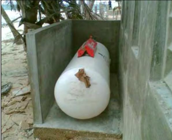
Para el caso de la Instalación de gas, se utilizará un tanque estacionario de 1,000 lt de capacidad para el almacenamiento de gas LP, para lo cual se contratarán el servicio de una empresa autorizada para su venta y distribución.
