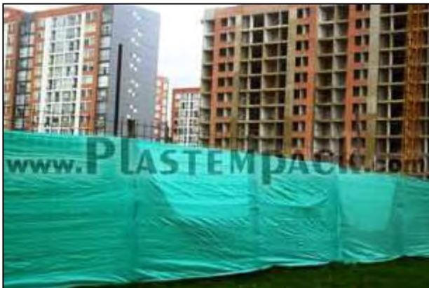
Una vez delimitada el área de trabajo se procederá a colocar una malla de plástico alrededor de las áreas de construcción, para que todo el personal obrero, proveedores de material, tengan conocimiento que es el área destinada únicamente para los trabajos de preparación del sitio y construcción.
