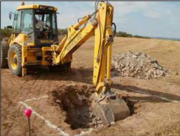
Para la cimentación se harán excavaciones de .30 m de ancho por .50 m de profundidad.
