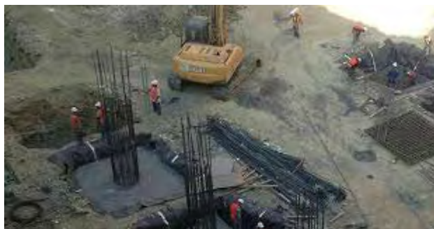
Figura IV-44 Ejemplificación de la medida de mitigación para aislar la construcción de la cimentación con el suelo y el manto freático
