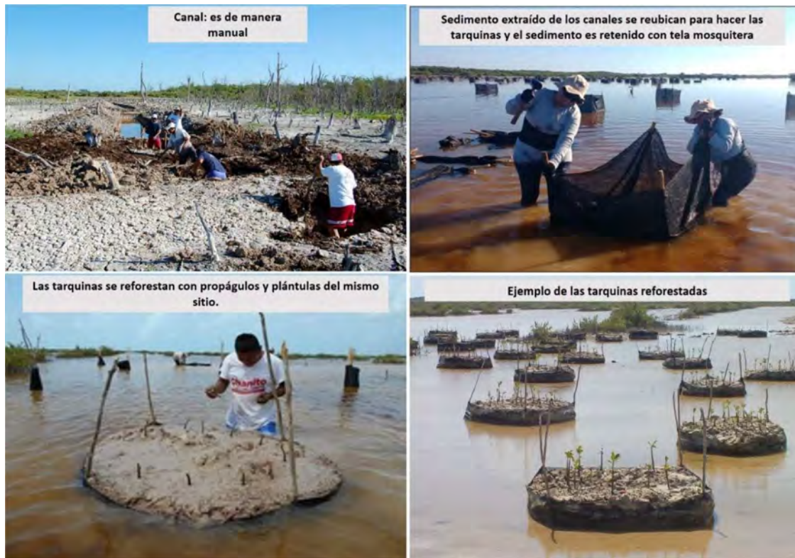
Figura 23. Ejemplo de elaboración de canales y plataformas de sedimento para facilitar la regeneración natural y acelerar el proceso a través de la reforestación. Fotos: Laboratorio de Producción Primaria, 2020.
