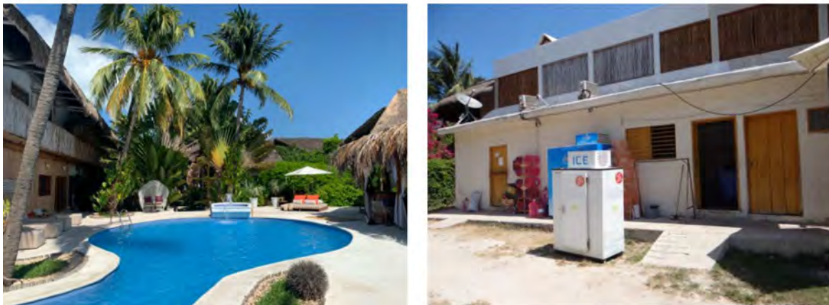
Fig. 7. Alberca y zona de servicios actuales que serán demolidos.
