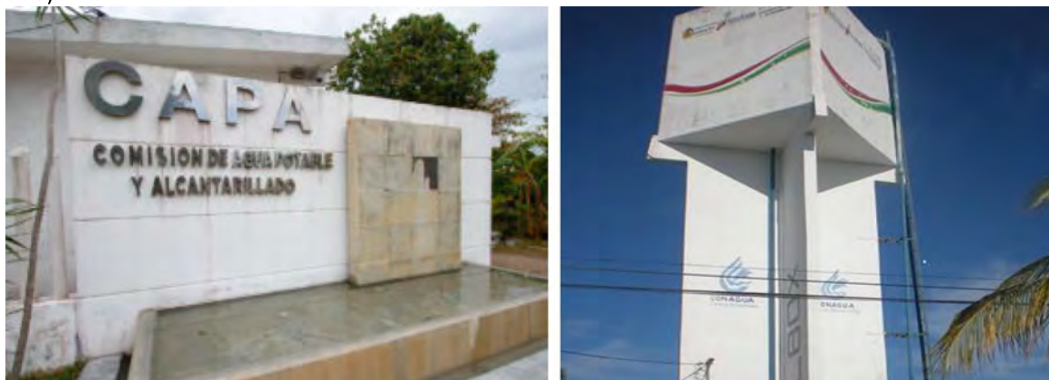
Fig. 23. Figura 1. Oficinas de la CAPA y cárcamo de agua potable de la isla de Holbox, Quintana Roo
