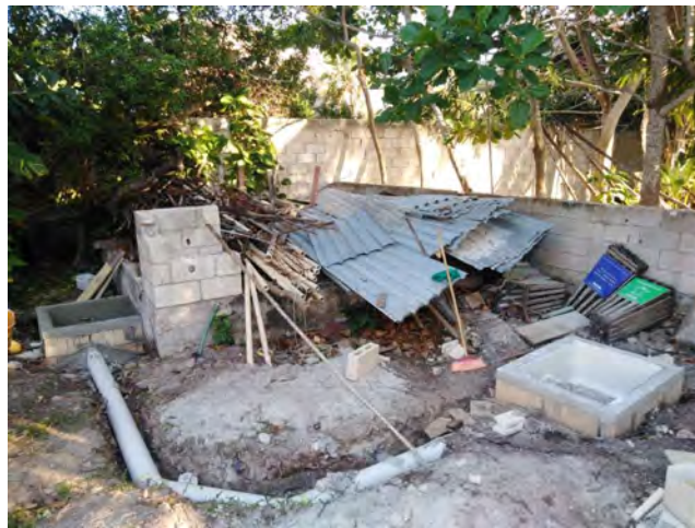
Fig. 10. Nuevas instalaciones hidrosanitarias del hotel que conducen las aguas negras hacia el sistema de alcantarillado de la isla.
