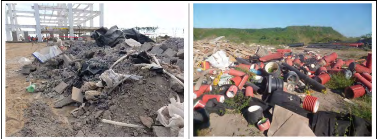
Figura II-19. Ejemplo de evidencias del mezclado durante la disposición temporal de residuos de manejo especial durante la etapa de construcción.
