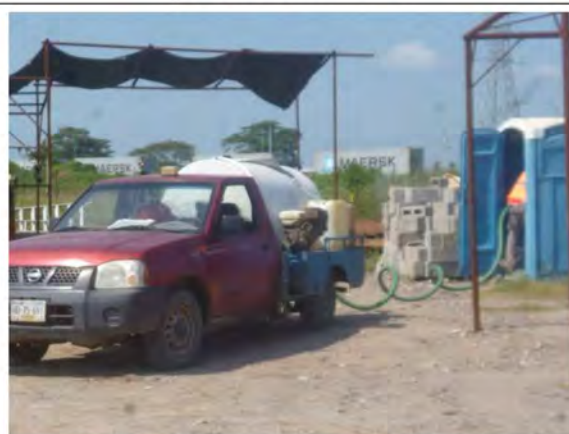
Mantenimiento a baños portátiles en un frente de trabajo por personal de una empresa especializada.
