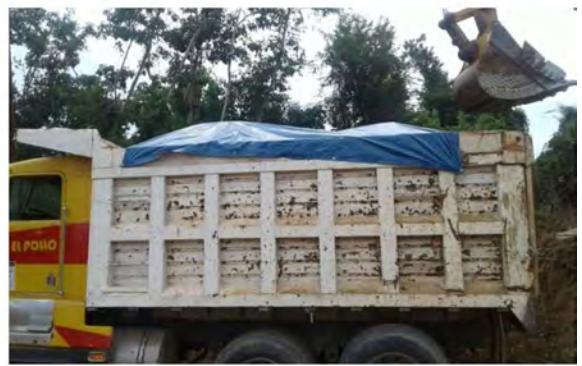
Transporte de material con protección para evitar la resuspensión de partículas
