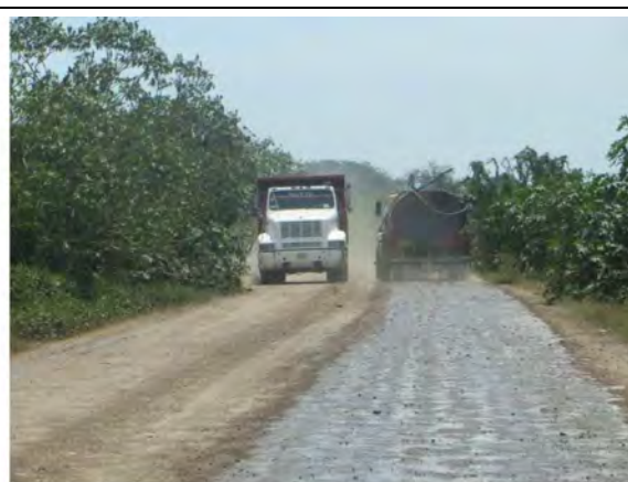
Aplicación de riegos para reducir la suspensión de partículas de polvo en el aire en los frentes de trabajo y circulación vehicular.
