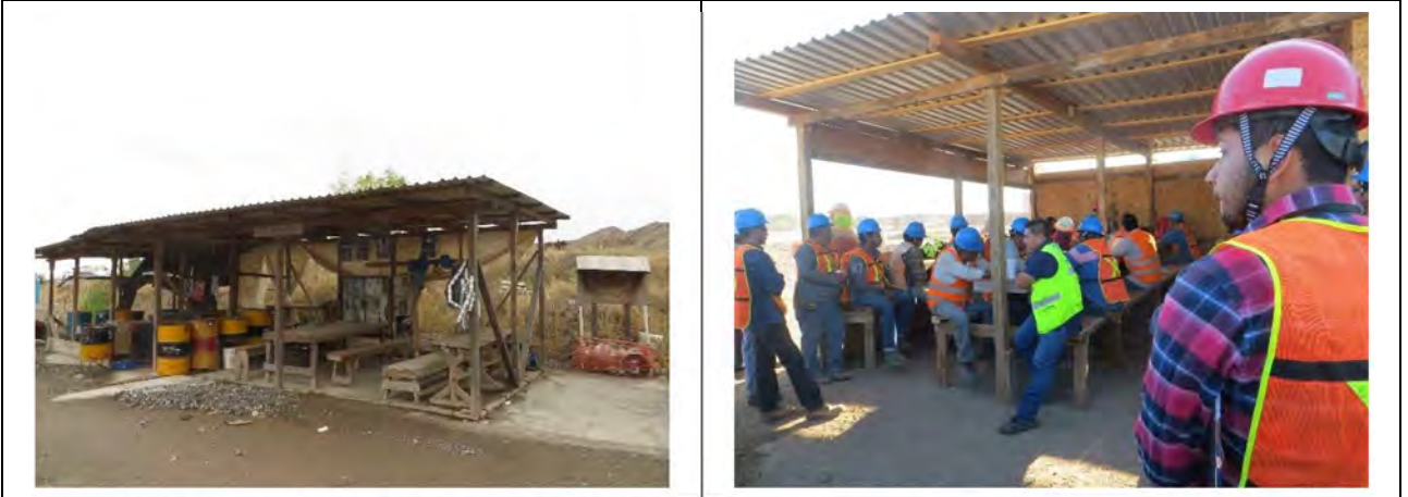
Figura II-13. Ejemplo de la habilitación de áreas para el consumo de alimentos y descanso para los trabajadores de obra durante la etapa de construcción.
