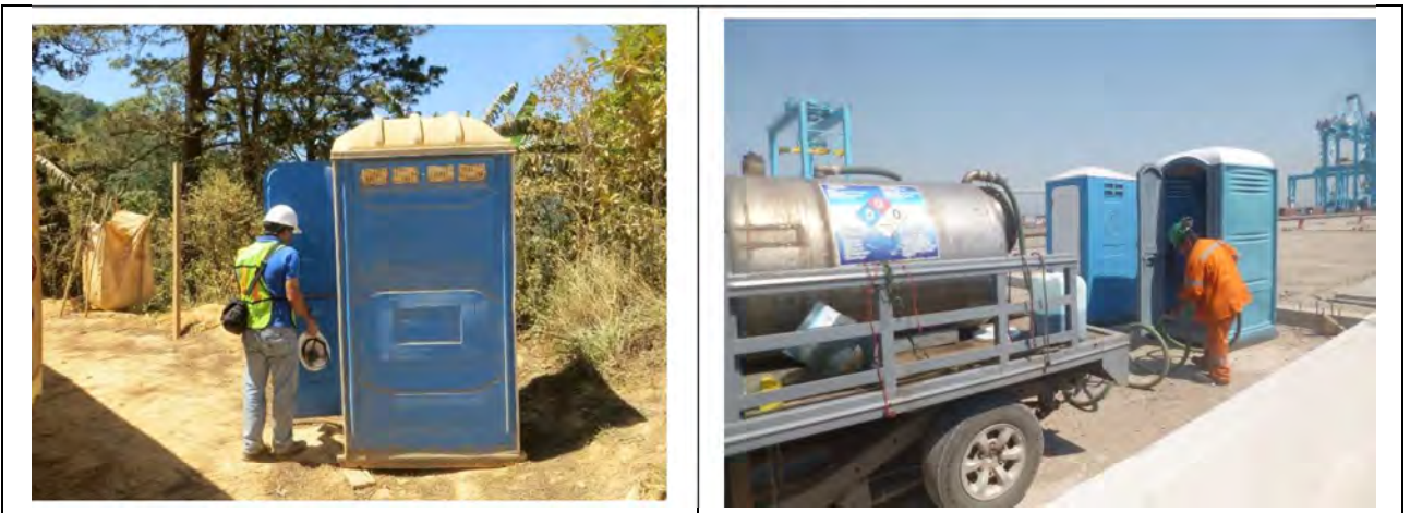
Figura II-14. Ejemplo de la habilitación y mantenimiento de baños portátiles instalados en frentes de trabajo para uso de los trabajadores.
