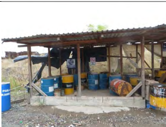
Protección de equipos contra fuga de hidrocarburos
