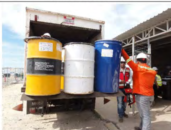
Recolección de suelo contaminado por derrame de hidrocarburos para disposición en el almacén temporal de residuos peligrosos
