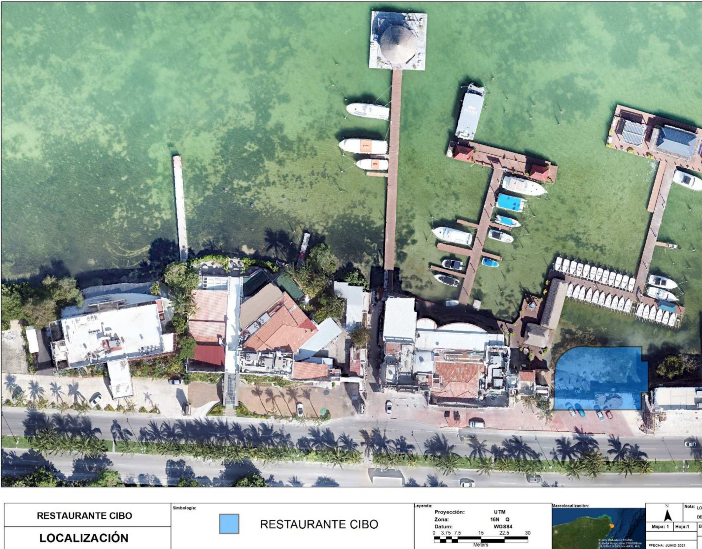
Figura 22. Localización del sitio del proyecto
