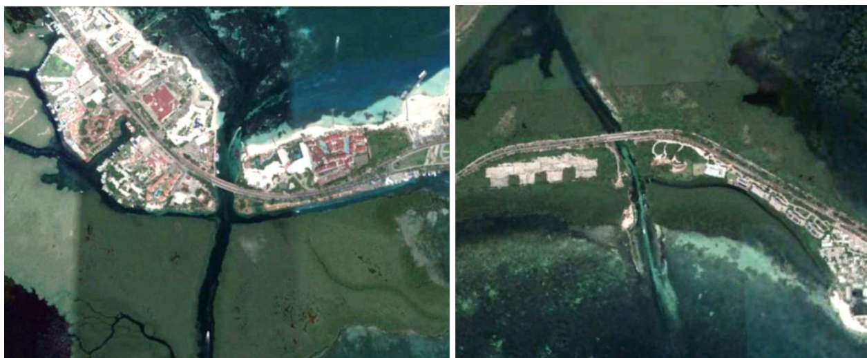
Figura 11. Bocas de comunicación (Norte-imagen izquierda; Sur-imagen derecha).
