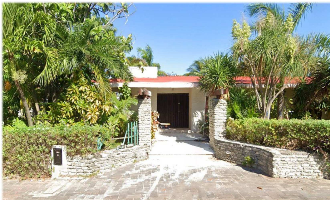
Fachada de la antigua casa que ha sido demolida para llevar a cabo la construcción del proyecto Torre 11. Las plantas del jardín serán rescatadas y llevadas a un vivero.
