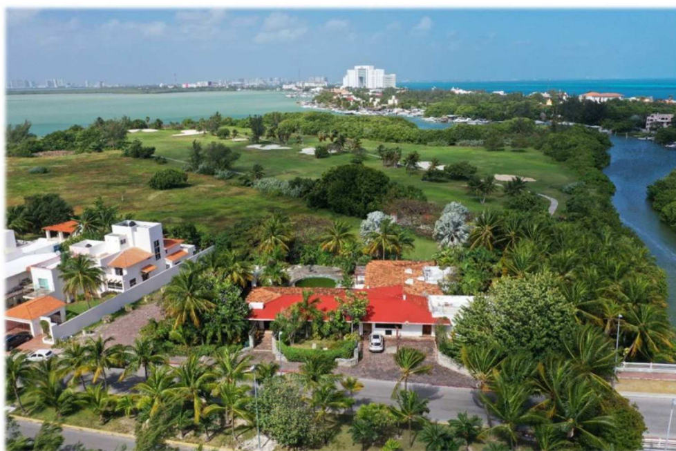
Entorno del predio. La localización del predio se caracteriza por ser urbano, con todos los servicios, y al mismo tiempo, se inserta en áreas naturales como la laguna Nichupté y sus ecosistemas ribereños. También se localiza en terrenos colindantes con el campo de golf Pok Ta Pok y una vialidad que le permite el acceso directo al Boulevard Kukulcán.
