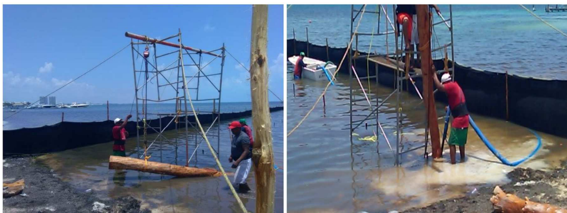
Figura 39.- Vista de malla perimetral colocada alrededor de muelle en proceso de construcción en aguas del Mar Caribe en la ciudad de Cancún.
