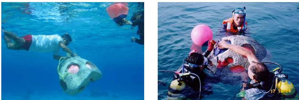
*Figura 12. Estructuras con boyas de polyform para un descenso controlado con apoyo de buzos.*
