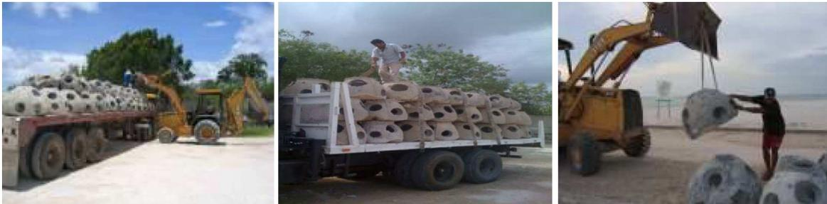
*Figura 10. Proceso de carga, transporte y descarga de estructuras de concreto Reef Ball.*
