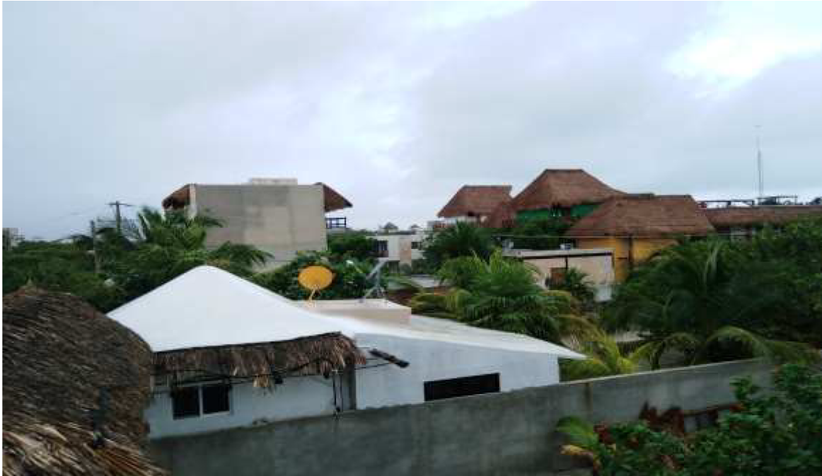
Infraestructura diversa colindante al suroeste del sitio del proyecto.
