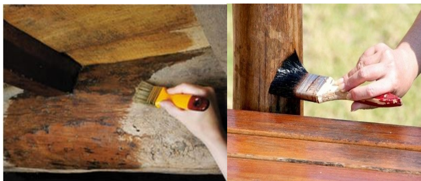
Figura II. 10 Ilustraciones que muestran la aplicación del barniz y el sellado.
