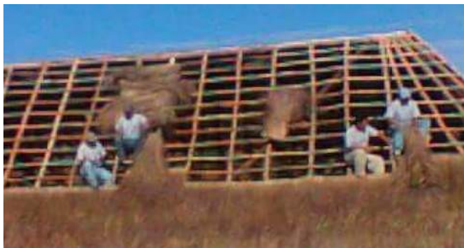
Figura II. 9 Colocación de zacate para el techo
