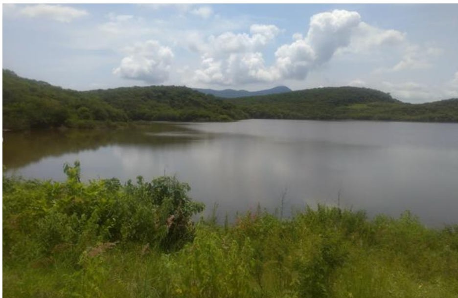
Fotografía II. 5 Fotografía de la presa Higueritas, fuente de agua para las actividades económicas de la región.
