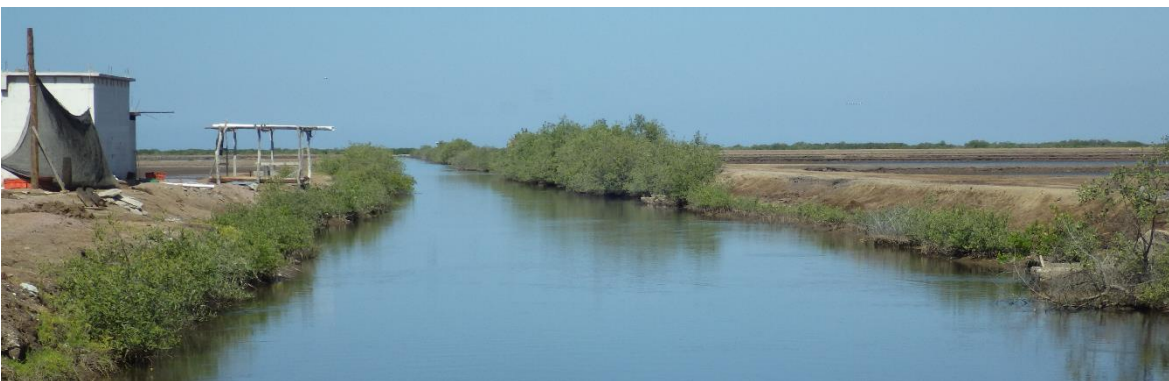
Dren de descarga y bodega
