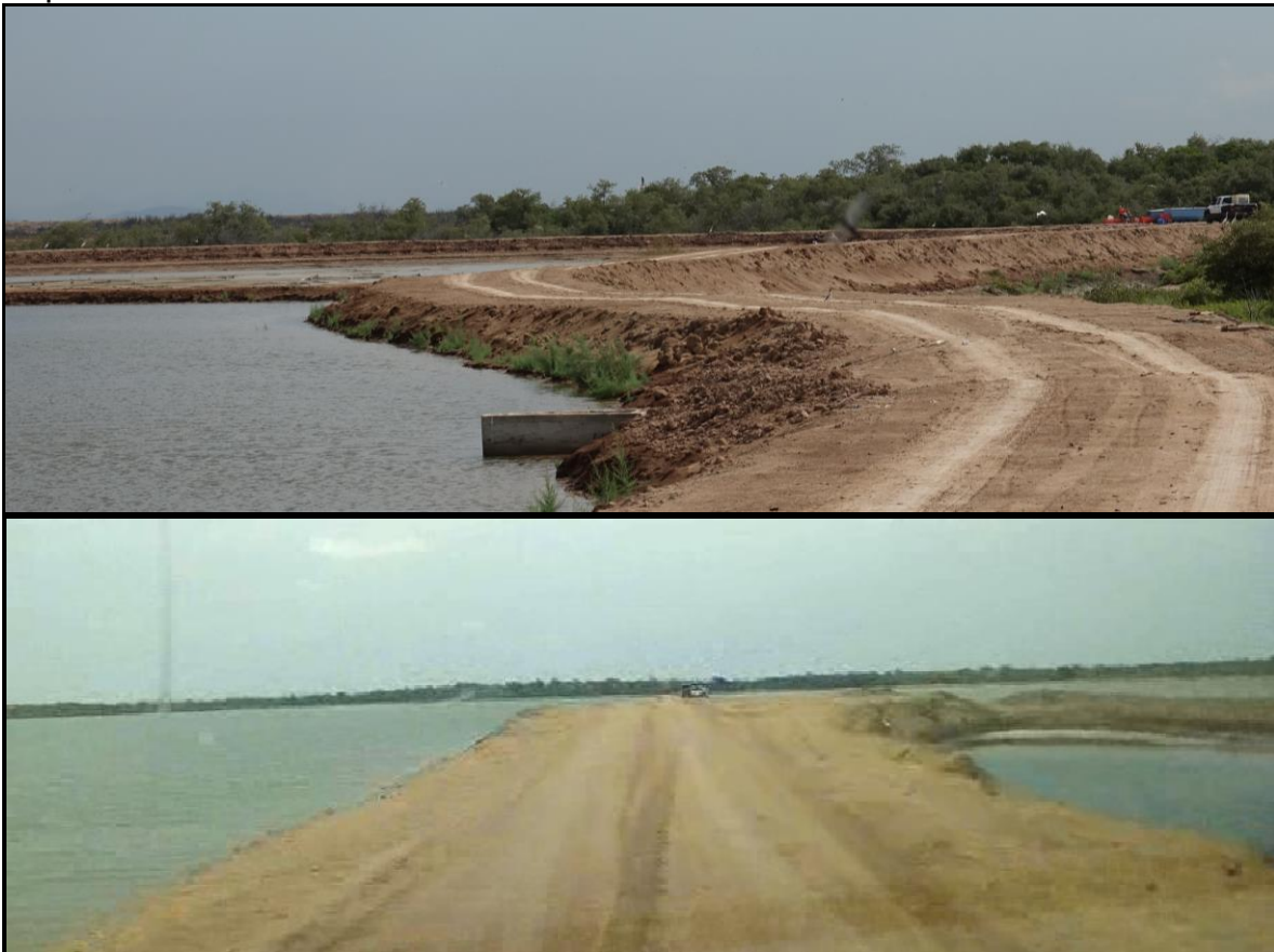
Detalle de los bordos de los estanques de la granja acuícola.
