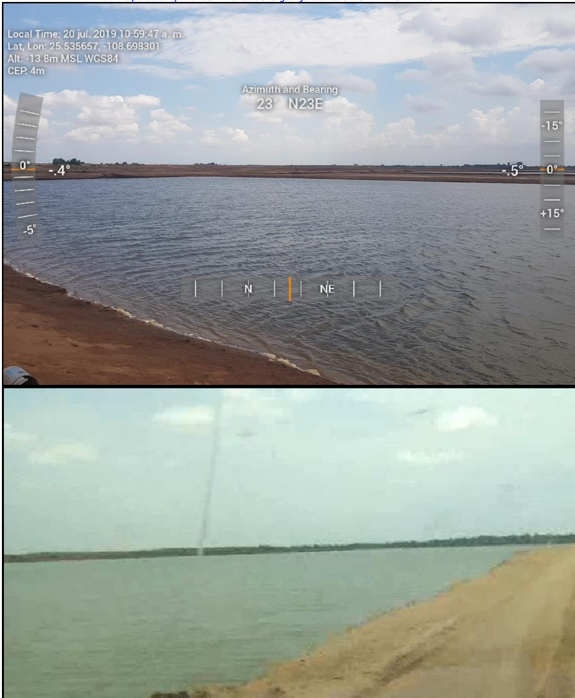
Vista parcial de uno de los estanques.
