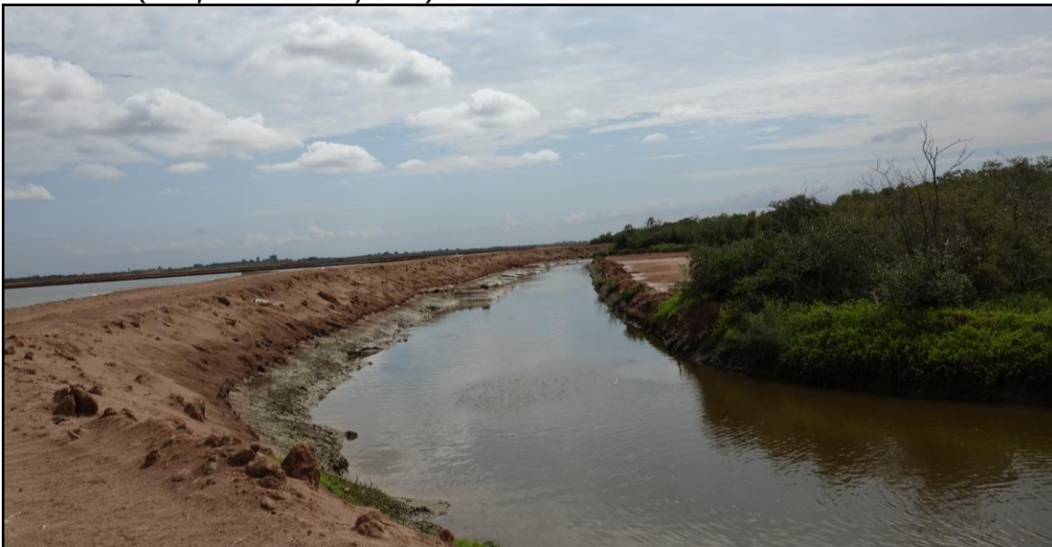
Otra panorámica del del perimetral para desagüe estanques No.1 al No.12.
