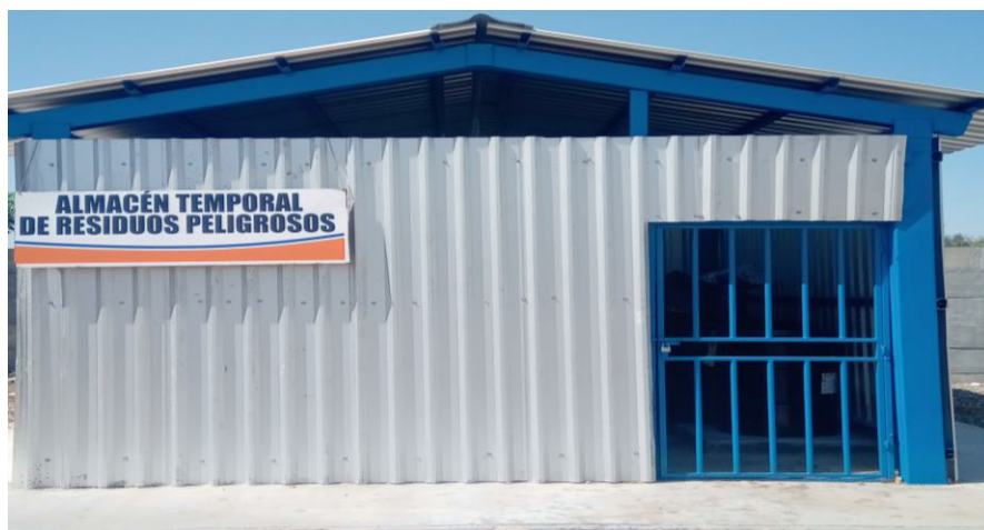
Imagen 21. Vista de almacén temporal de residuos peligrosos.
