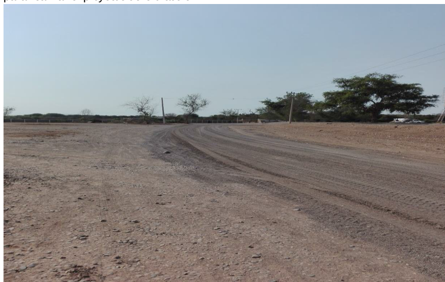
Imagen 18. Vista de camino de terracería
