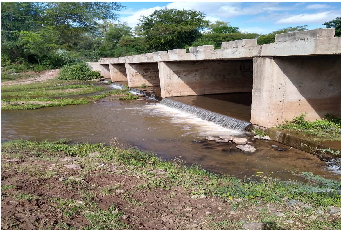
Imagen 41. Vista inferior del puente que cruza el polígono del proyecto.
