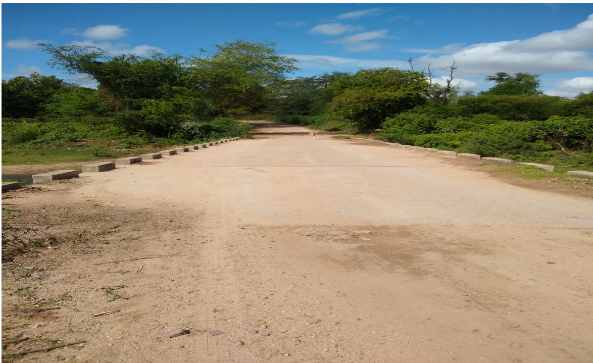
Imagen 42. Vista superior del puente que cruza el polígono del proyecto.
