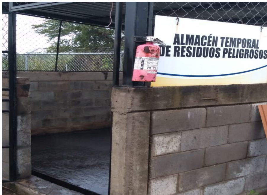
Imagen 17. Vista de almacén temporal de residuos peligrosos.
