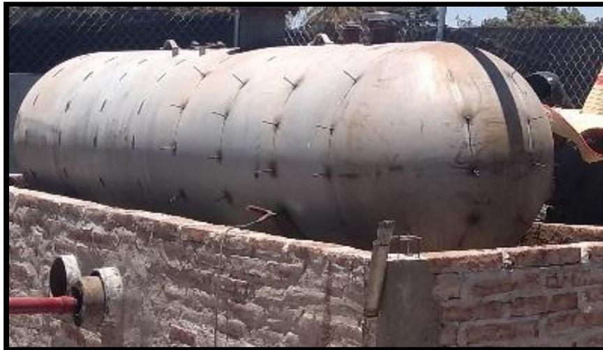
Foto 5. Tanque de trabajo horizontal de 5000 litros en construcción.
