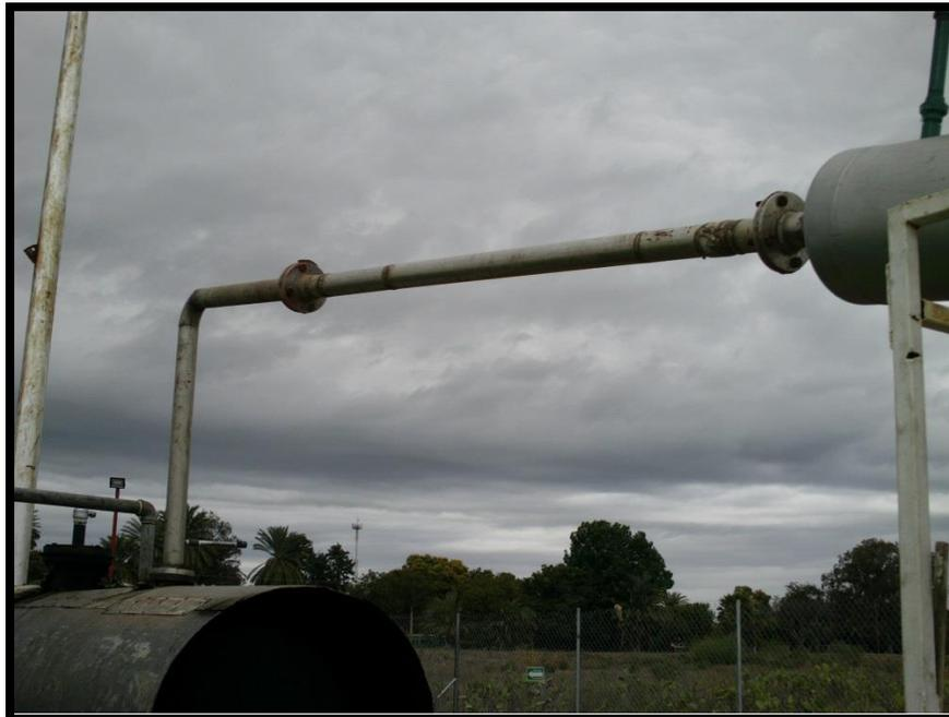
Foto 7. Los vapores saldrán del tanque de trabajo de 5000 litros y entrarán a un primer condensador.
