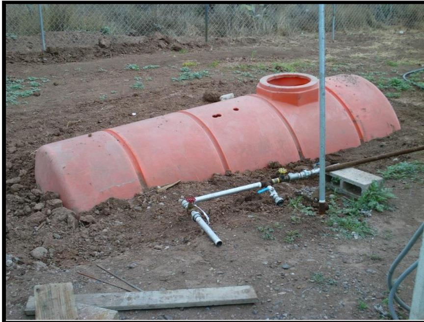
Foto 13. Tanque de almacenamiento de agua para torre de enfriamiento.
