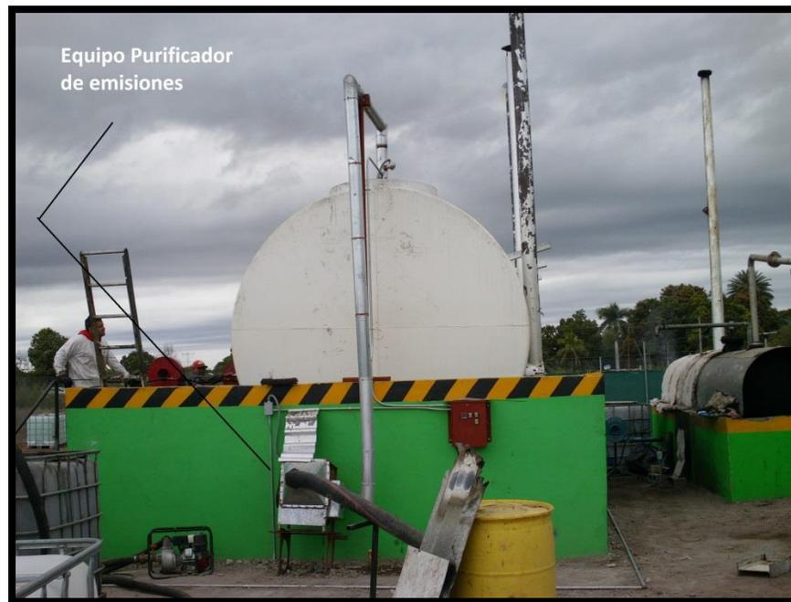
Foto 4. Tanque de desmetalización de aceite y evaporación de agua.
