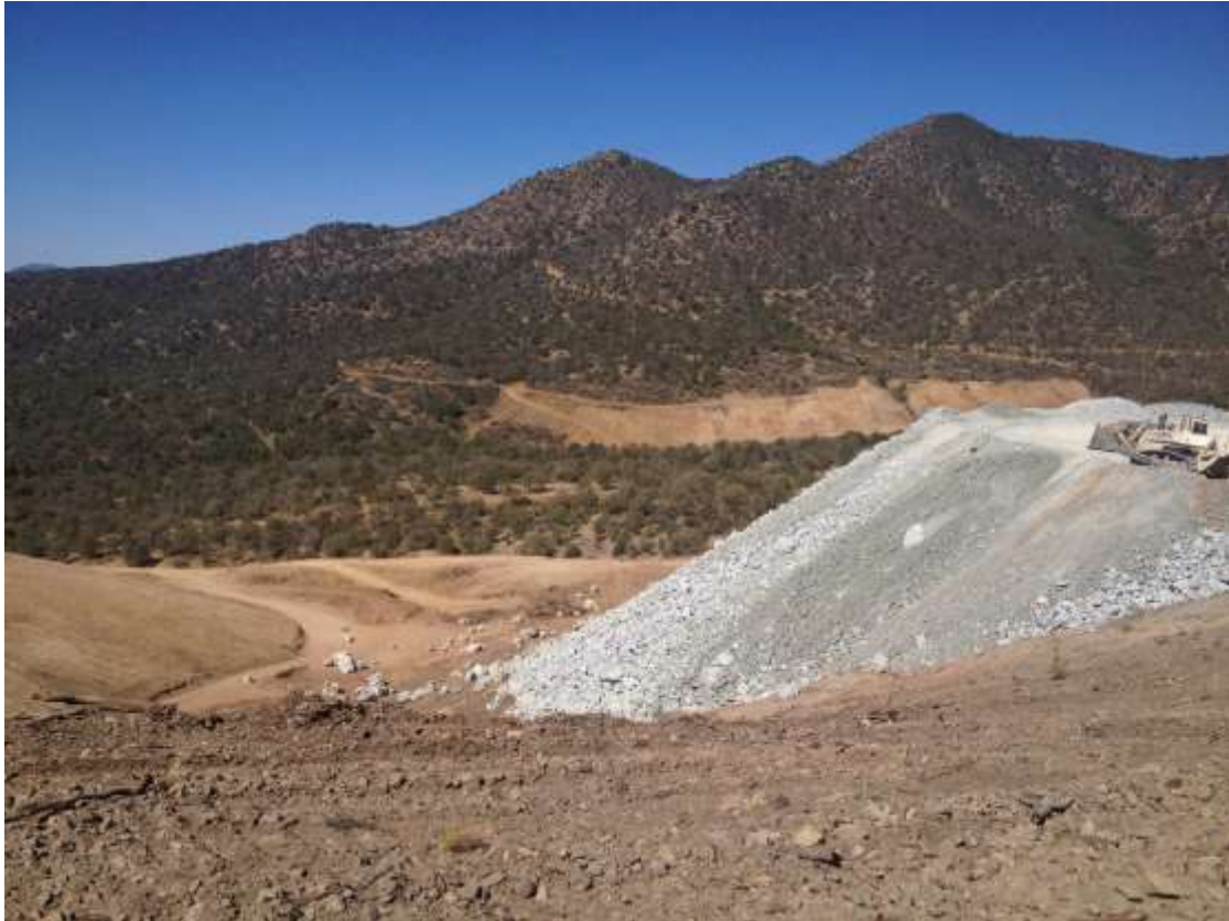
Figura 7.11. Vista hacia el norte del Sistema Ambiental del Proyecto y de una parte del material llamado tepetate que es colocado en el sitio conocido como tepetatera.
