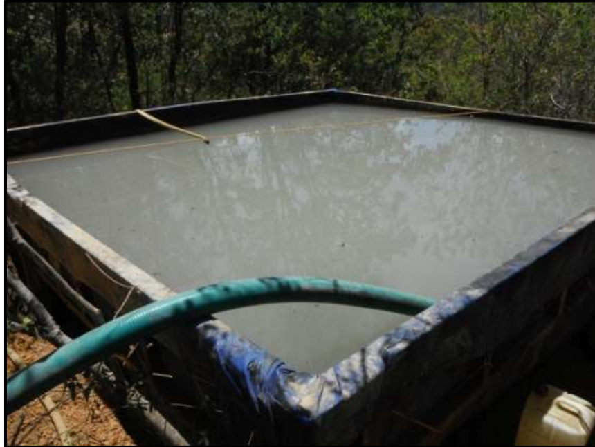
Figura II. 7 Llenado del cárcamo portátil de lodos
