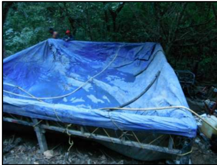
Figura II. 6 Armado del cárcamo de lodos
