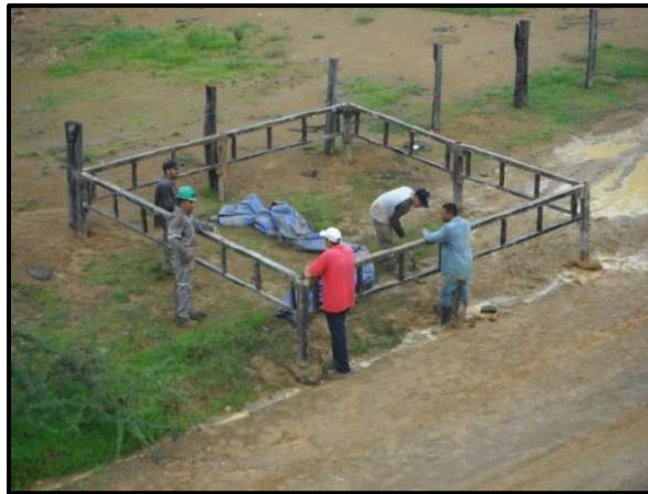
Figura II. 19 Material impermeable que cubre el área de desplante de la máquina de barrenación
