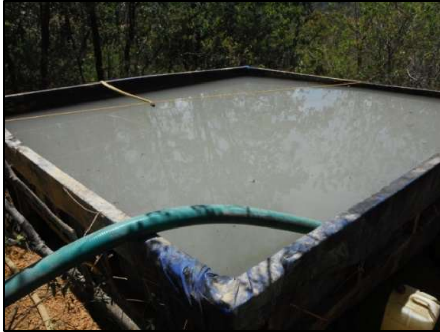
Figura II. 20 Llenado del cárcamo portátil de lodos
