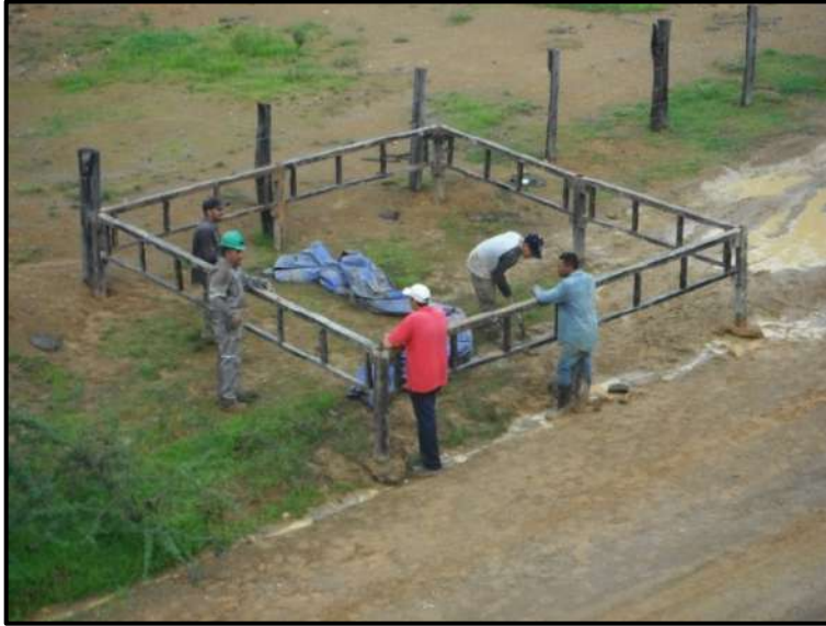
Figura II. 5 Material impermeable que cubre el área de desplante de la máquina de barrenación
