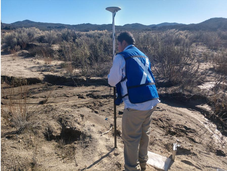
Fotografía 13. Que muestra levantamiento topográfico del cauce.
