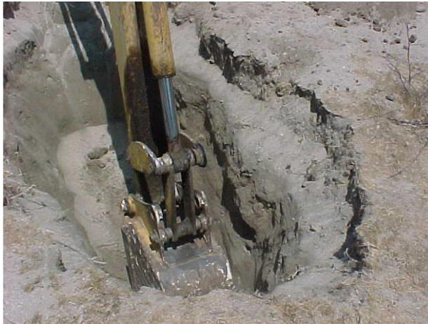
En la profundidad excavada no se encontró el nivel freático en las excavaciones que se efectuaron con una retroexcavadora.
