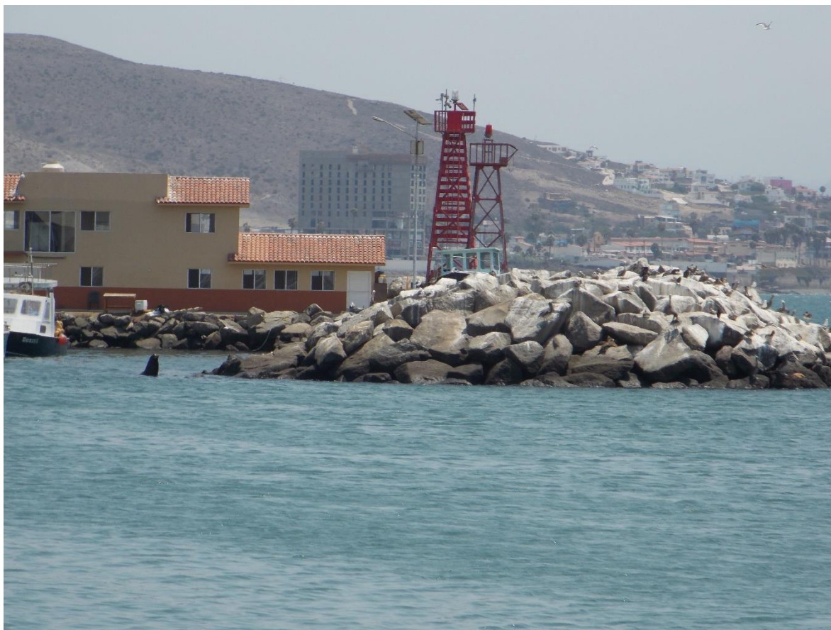
Fotografía IV. Presencia de Zalophus californianus dentro del área del Recinto Portuario de El Sauzal.
