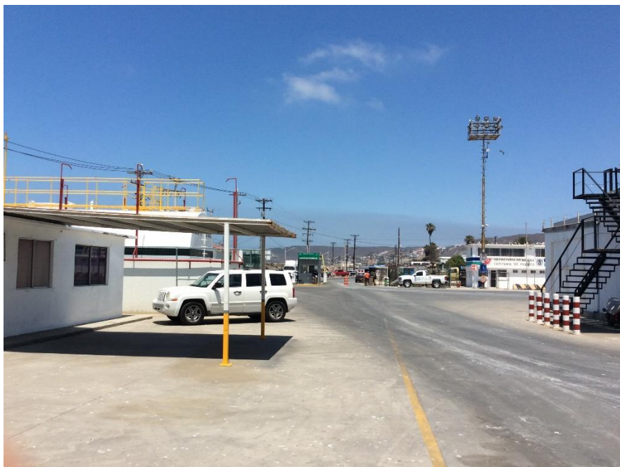
Fotografía VIII. Vista hacia el Norte desde la ubicación del proyecto.
