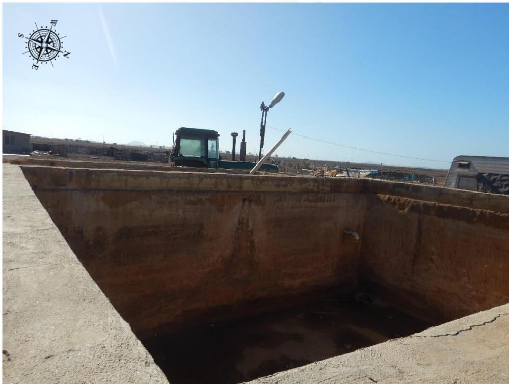
**Foto 2.** Pila de concreto donde se recibirá el agua de los pozos.
