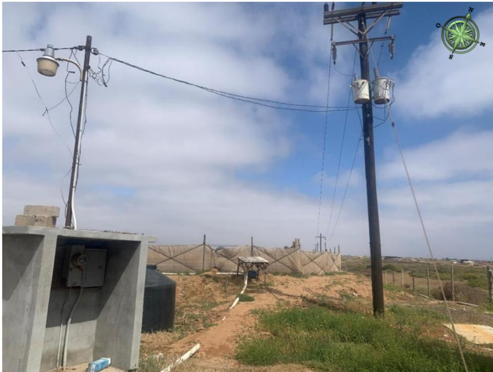
**Foto 1.** Subestación eléctrica de dos capacitores de 15 Kva que será remplazado por uno de 145 Kva.
