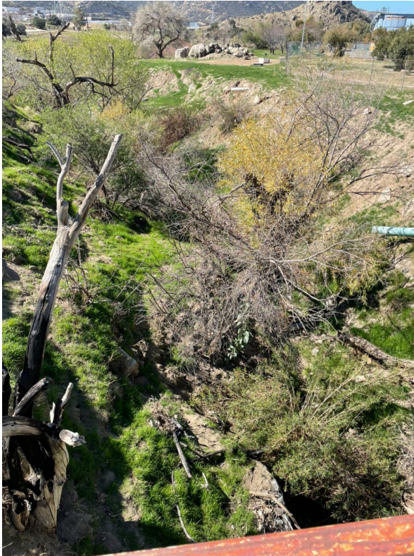
Vista del cauce del Arroyo San Pablo.
