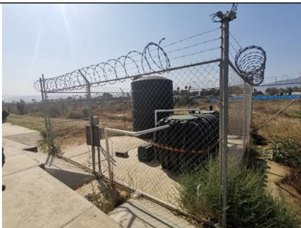
Ilustración 18 Vista de la PTAR 1, lado Oeste
