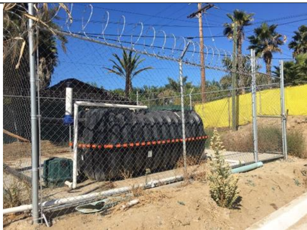
Ilustración 19 Vista de la PTAR 2, lado Este
