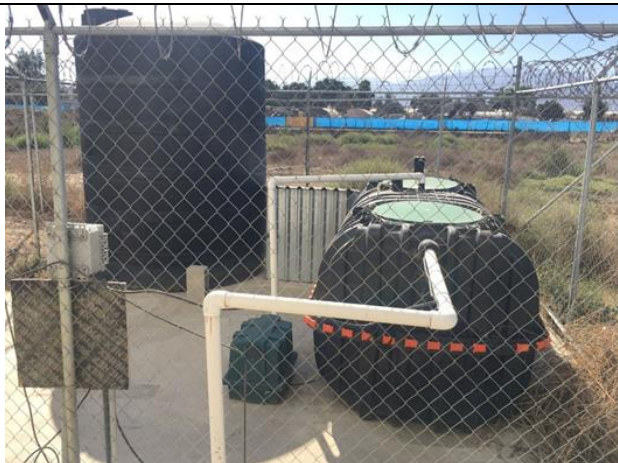
Ilustración 15 Vista de la PTAR 1, lado N
