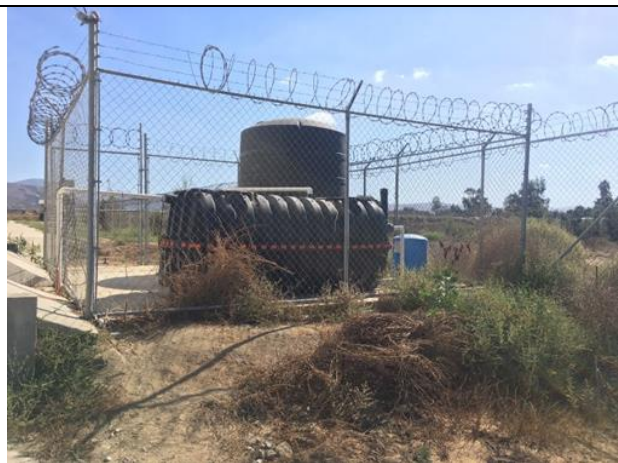
Ilustración 17 Vista de la PTAR 1, lado Oeste
