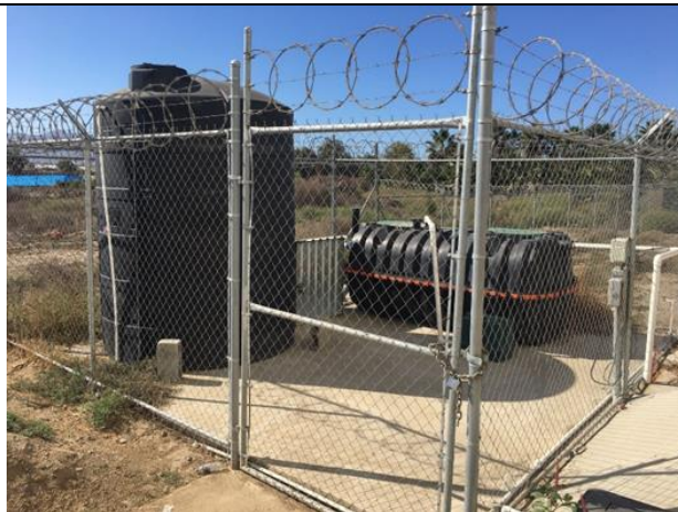
Ilustración 16 Vista de la PTAR 1, lado NE
