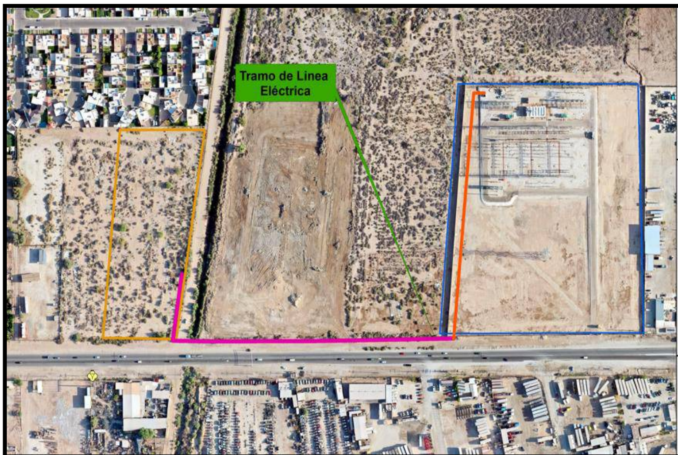
Ilustración 2 Escenario posterior al desarrollo del proyecto, en la presente ilustración se aprecia: predio de generación, línea eléctrica, punto de interconexión de gas natural y subestación eléctrica Mexicali Oriente
