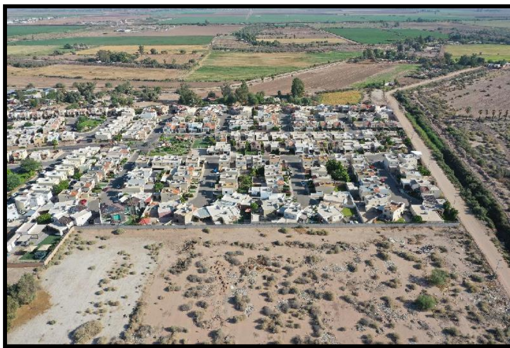
Ilustración 5 Colindancia Norte - Fraccionamiento privado
