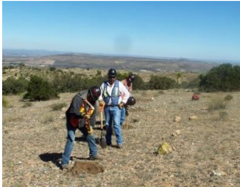
Figura II. 10 Apertura de cepas con el uso de palas redondas y picos (imagen empleada solo de forma ilustrativa)
