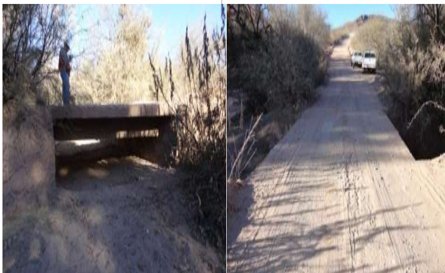
Vista lateral y de frente del puente existente
