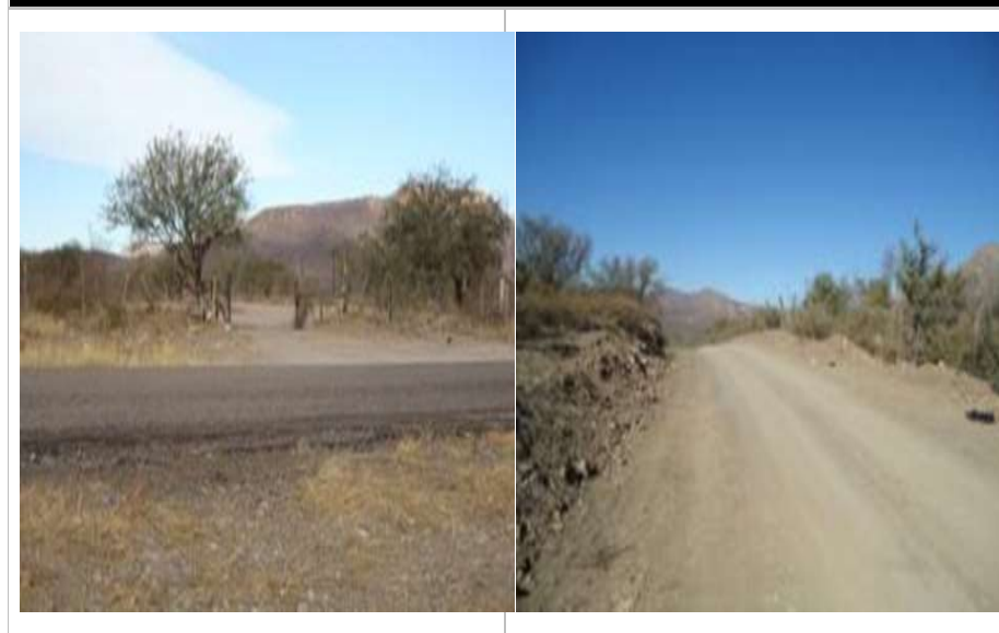
Inicio de obra Entronque Mex45-Abasolo (acceso principal)
