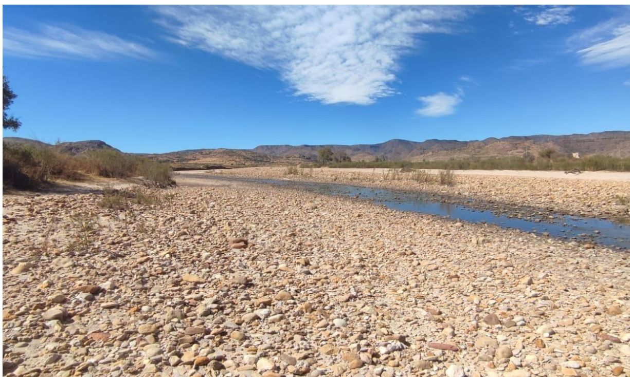
Ilustración 4.- Panorámica de áreas propuestas para aprovechamiento de materiales pétreos en greña en el cauce de Arroyo El Carpintero
