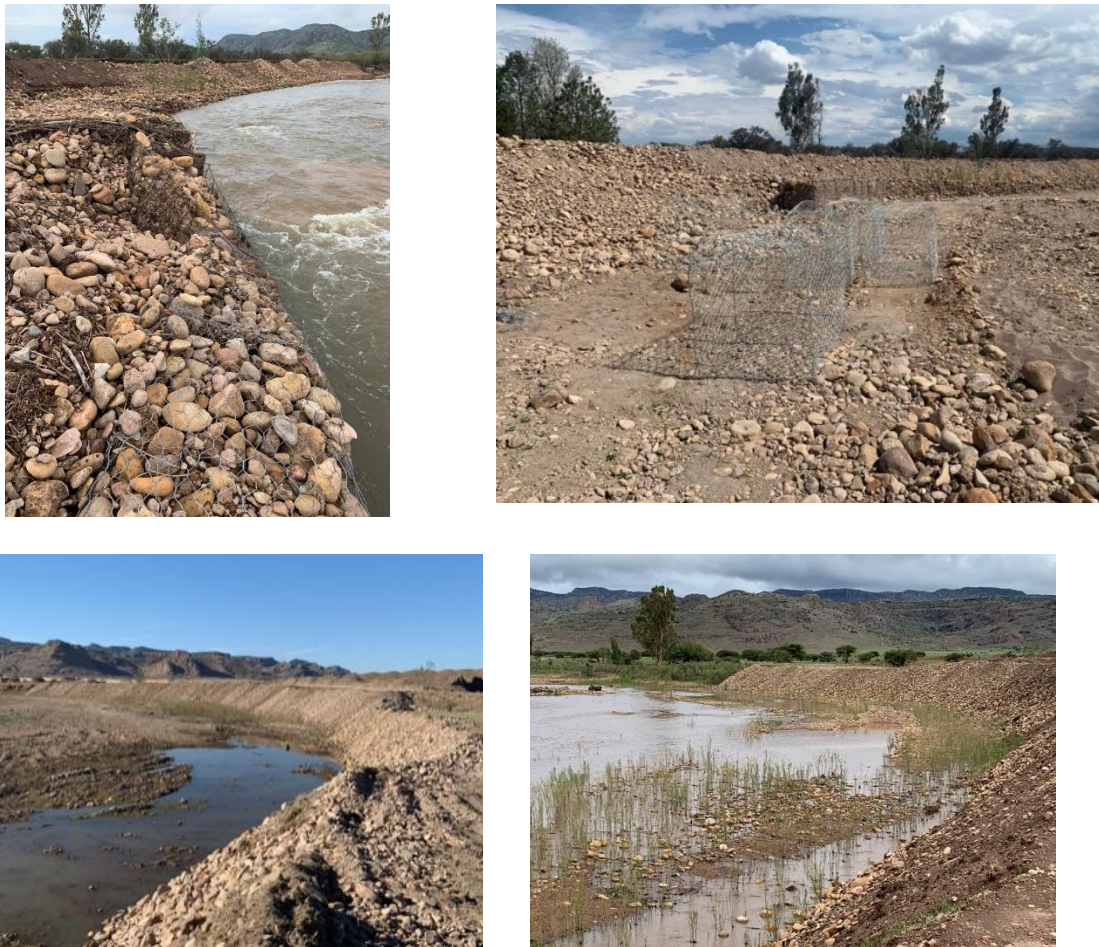
Fig. 53. Obras de protección de los taludes del arroyo.
