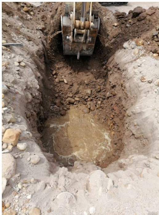
Fig. 56. Trabajos para pruebas PCA.
