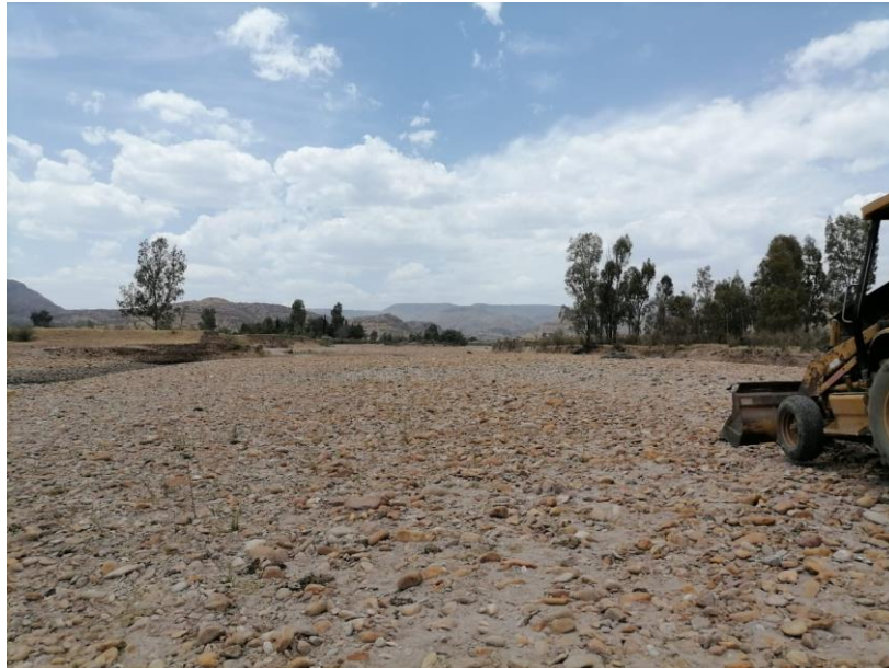
Fig. 55. Trabajos para pruebas PCA.
