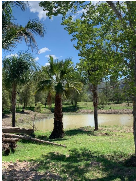
Terreno particular a un costado del arroyo que ya colapsó
