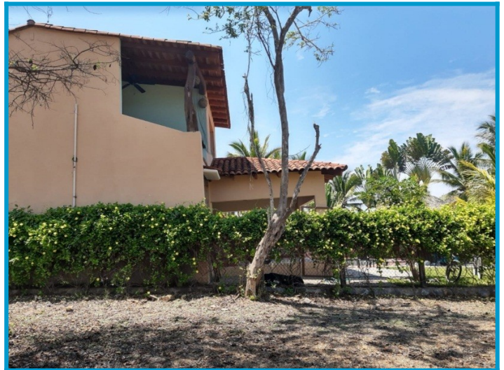
Foto 2.- Colindancia al este con casa habitación
