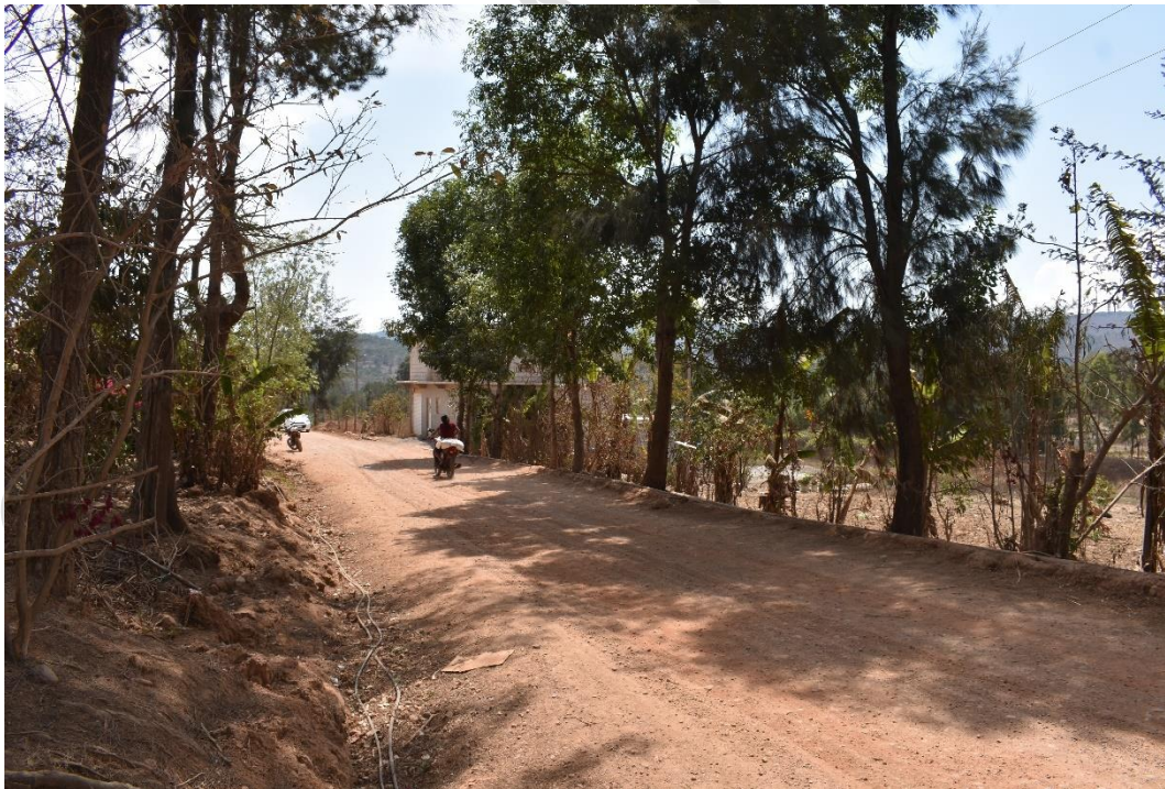
Fotografía 5 y 6. Callejón existente el cual se encuentra ubicado a la altura del Km 3+000 del camino a construir, nótese la superficie semiplana existente en el sitio.
