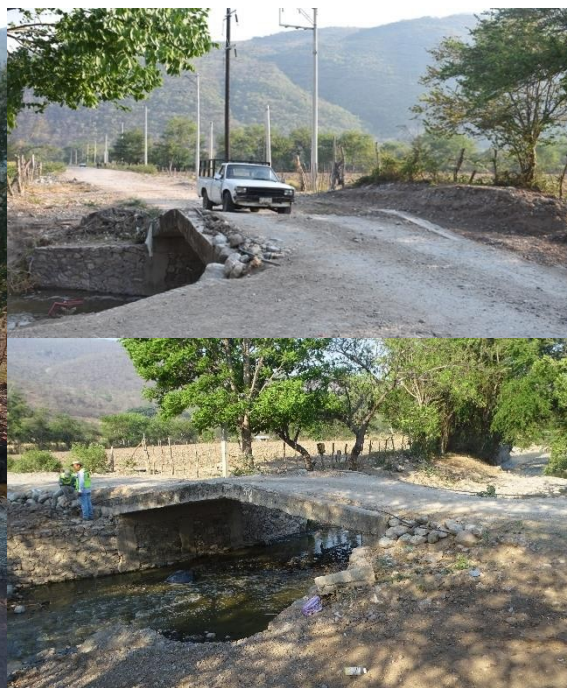
Fotografía 27, 28 y 29. Vista frontal y lateral del puente existente a base de concreto.
