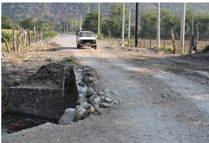
Fotografías 10. Condiciones actuales del del puente vehicular, nótese el deterioro que presenta actualmente y el ancho de 3 metros.
