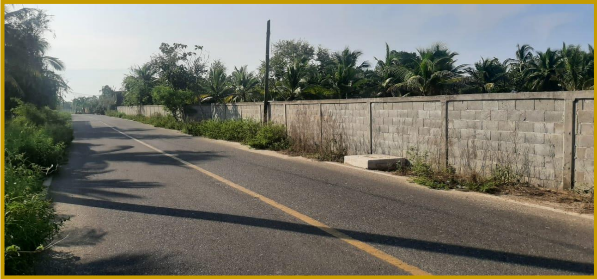
Ilustración VIII.3.2. Servicios de electrificación de la CFE del lote 36.
