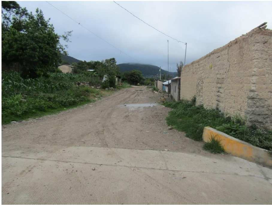
Figura 58. Servicios públicos básicos de La Esperanza (Calle sin pavimentar).
